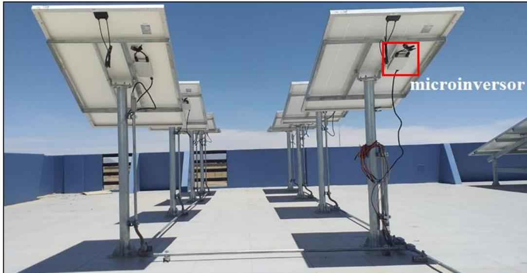
**Figura 1.** SFCR con microinversor instalados en monopostes en el Instituto de Energías Renovables y Eficiencia Energética de la UNAJ sede Ayabacas.
