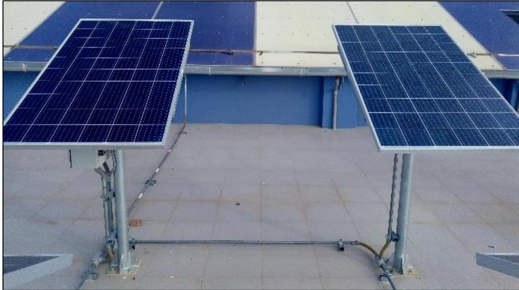
**Figura 9.** Módulos fotovoltaicos Talesun de 270Wp compuesto por 60 celdas de silicio policristalino.
