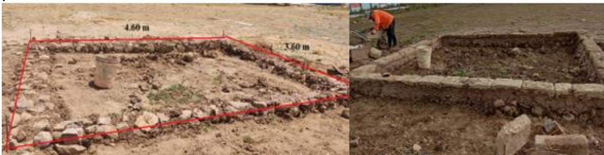
**Figura 53.** Especificaciones de cimentación y levantamiento de muro.
