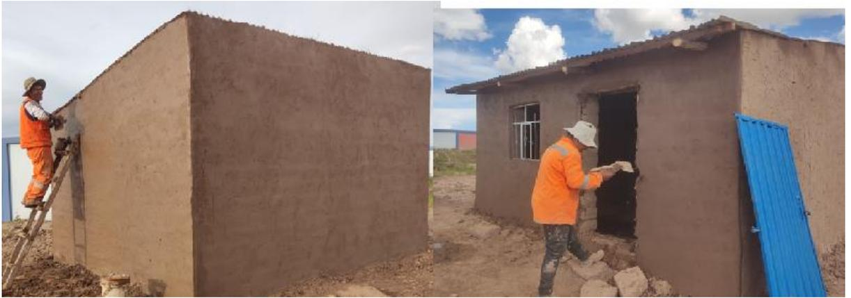
**Figura 56.** Acabado exterior y colocación de puertas y ventanas.
