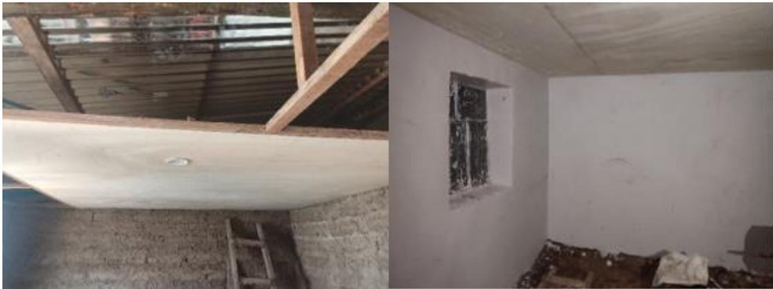
**Figura 57.** Colocación de techo falso y acabado interior.
