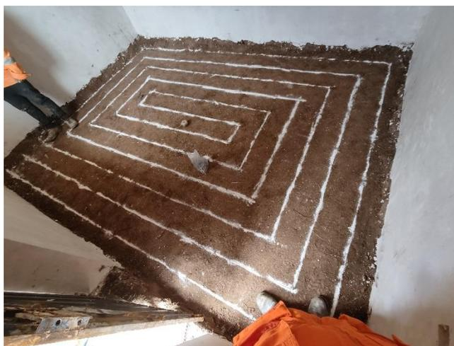
**Figura 59.** Nivelado, compactado y trazado del piso se la vivienda.
