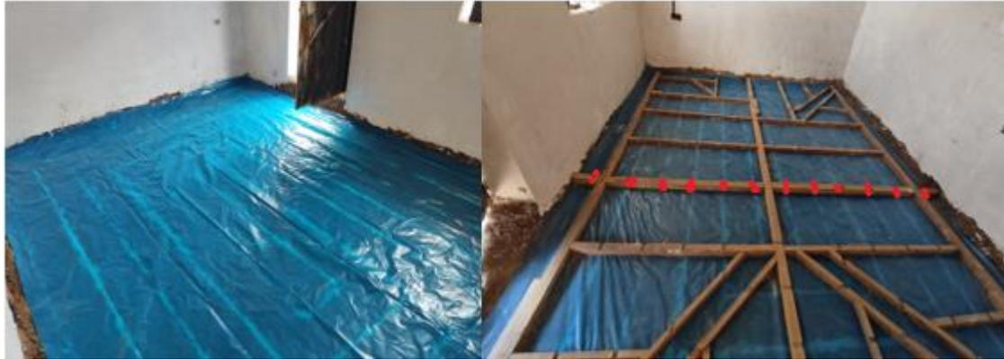
**Figura 60.** Tendido de polietileno en piso y armado de guía y soporte del serpentín. El tendido de poliestireno encima del polietileno fortalece el aislamiento térmico del piso, para que la pérdida de calor por el piso sea mínima y que el calor que emiten las tuberías tanto cobre y pex sea hacia el interior de la vivienda, la figura (a) es tubería de cobre y la figura (b) es tubería Pex.
