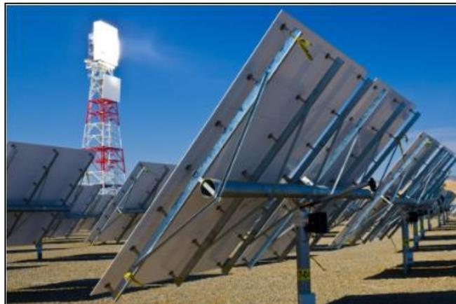
**Figura 17.** Heliostato con receptor central en torre (Clementi, 2020).
