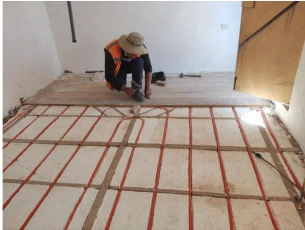
**Figura 62.** Instalación de la bomba y entablado con madera machihembrada.
