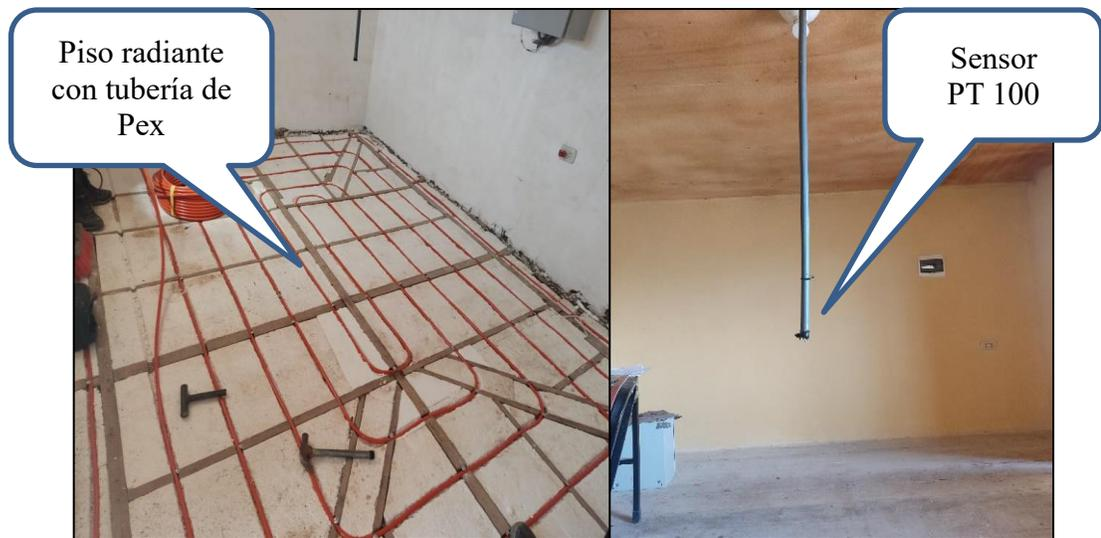
**Figura 38.** Ubicación del piso radiante con tubería Pex y sensor PT 100.
