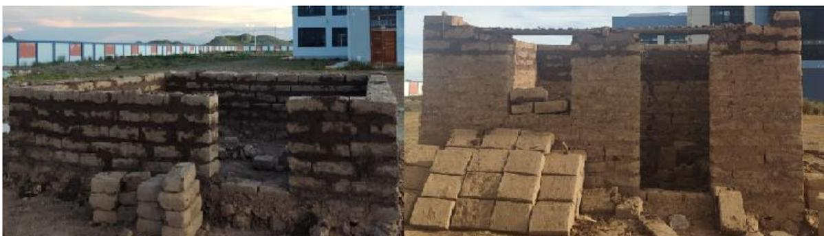
**Figura 54.** Levantamiento de paredes de la vivienda.
