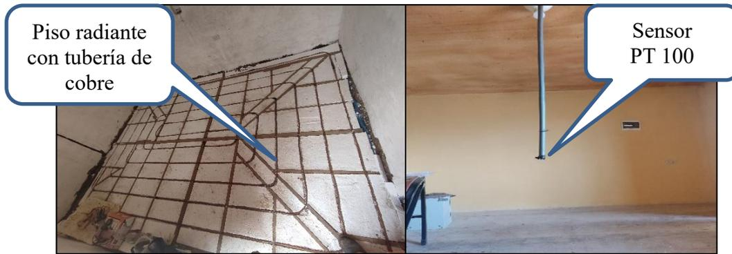
**Figura 34:** Ubicación del piso radiante con tubería cobre y sensor PT 100.
