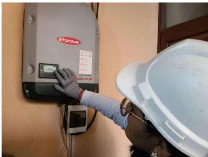
Figura 3.5.7 Montaje del inversor de red Fronius PRIMO 5.0-1.
