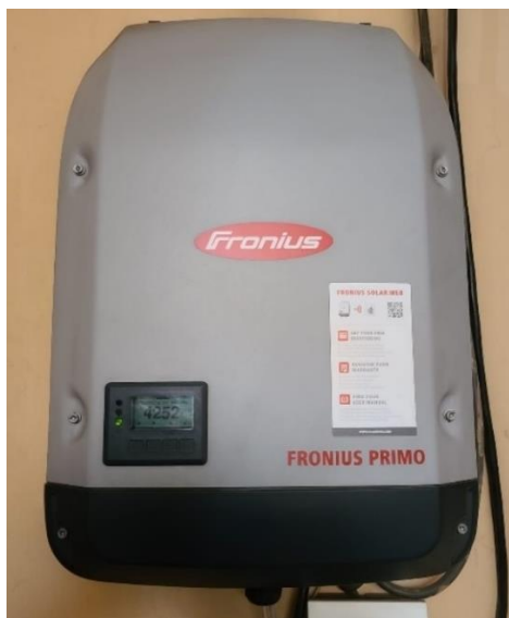
Figura 3.5.8 Puesta en marcha del inversor de red Fronius PRIMO 5.0-1.
