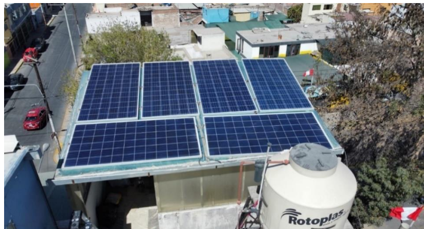
Figura 3.5.9 Distribución de seis módulos del SFCR – Independencia.
