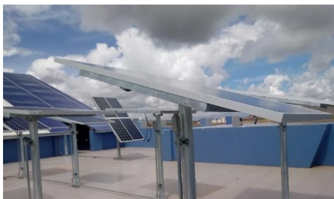
Figura 3.30. Montaje de los módulos fotovoltaicos adaptación propia.
