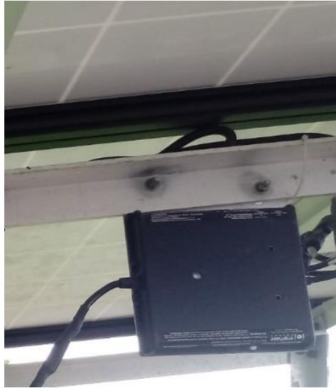
Figura 3.31. Instalación del microinversor M215 adaptación propia.
