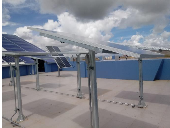
Figura 3. 32. Instalación del entubado del sistema fotovoltaico adaptación propia
