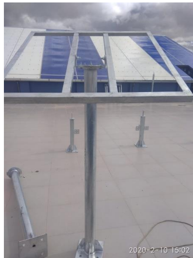
Figura 3.29. Montaje de la estructura de soporte adaptación propia.
