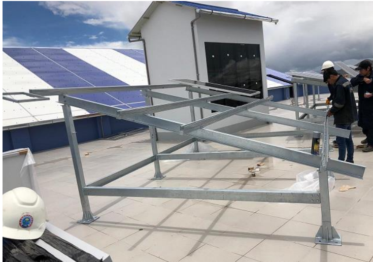
Figura 3.30: Armado de la estructura de soporte terminada (Elaboración propia).
