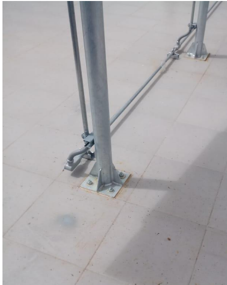
Figura 3.34: Instalación de la tubería EMT galvanizada para protección interna del cableado (Fuente propia).
