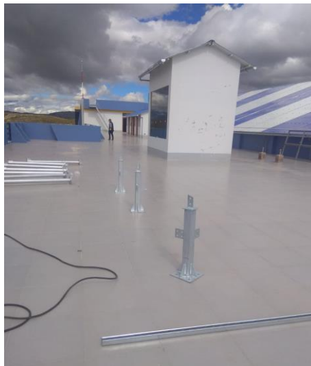
Figura 3.29: Armado de la estructura de soporte; e) verificación de las características diseñadas; f) inicio del armado (Elaboración propia).
