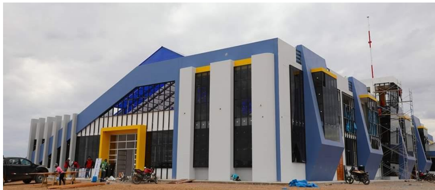
Figura 3.27: Infraestructura del Instituto de Energías Renovables y Eficiencia Energética (Fuente Propia).
