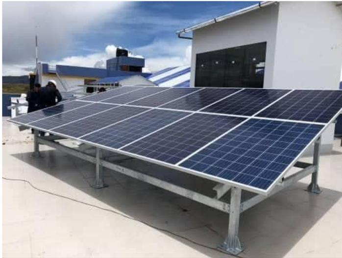
**Figura 3.19.** Montaje culminado del generador fotovoltaico (Fuente propia).
