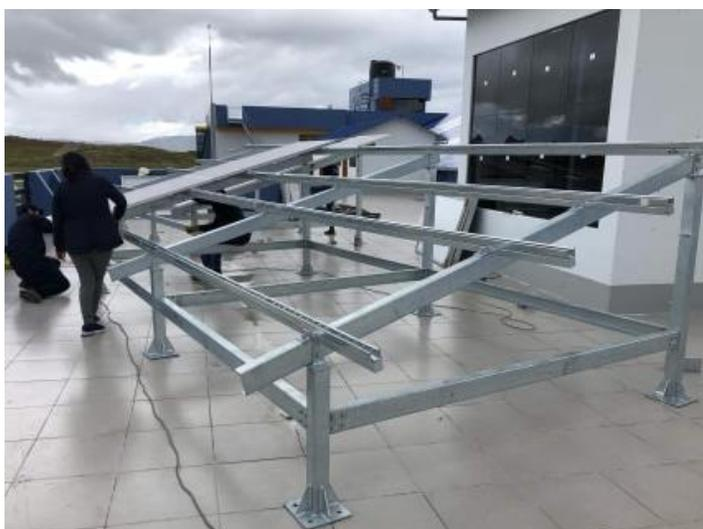
**Figura 3.17.** Montaje culminado de la estructura de soporte (Fuente propia).
