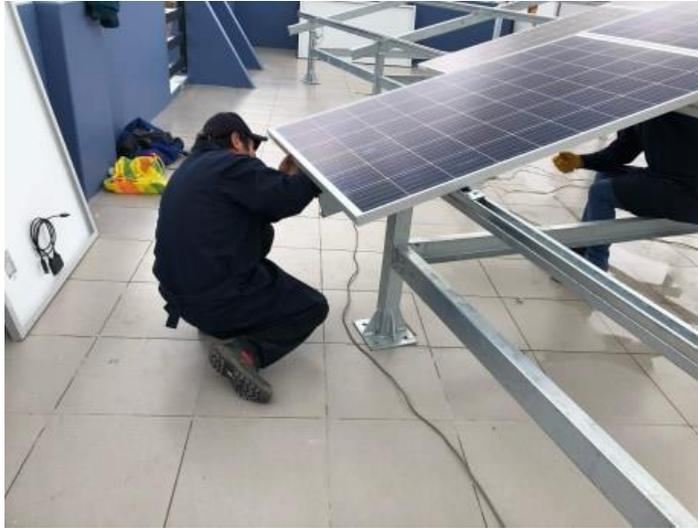
**Figura 3.18.** Montaje de los módulos fotovoltaicos (Fuente propia).
