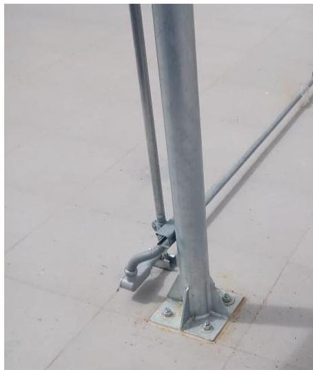
**Figura 3.21.** Instalación de tuberías EMT galvanizada para la protección de los conductores (Fuente propia).
