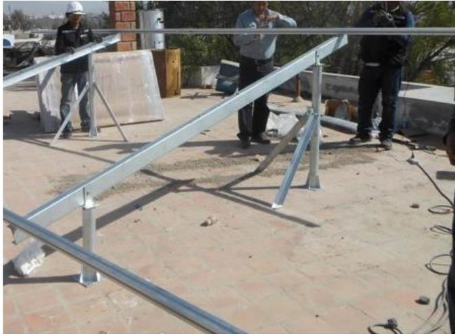
**Figura 12.** Preparación del soporte metálico para la instalación de los 12 módulos fotovoltaicos.
