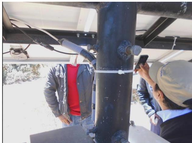
**Figura 11. Interconexión de módulos fotovoltaicos y peinado de cables.**
