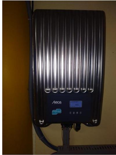
**Figura 10. Inversor para la conexión a red marca STECA.**
