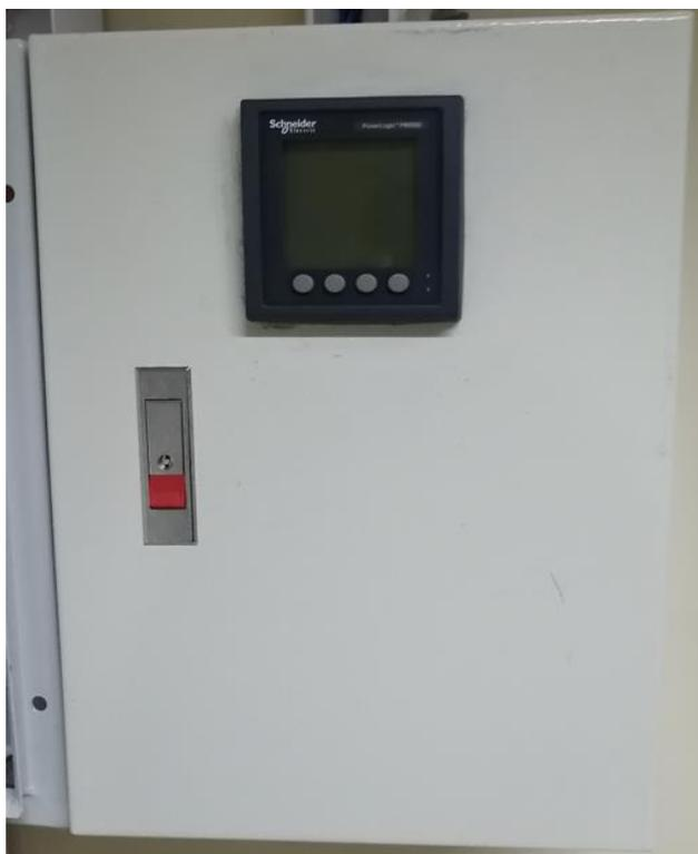
*Figura 20.* Tablero vista externa del Analizador de redes PM5560
