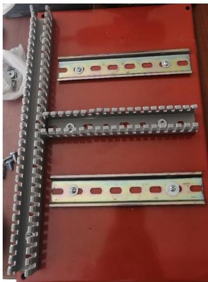
Figura 18. Armado de tablero parte interna, carriles, canaletas.
