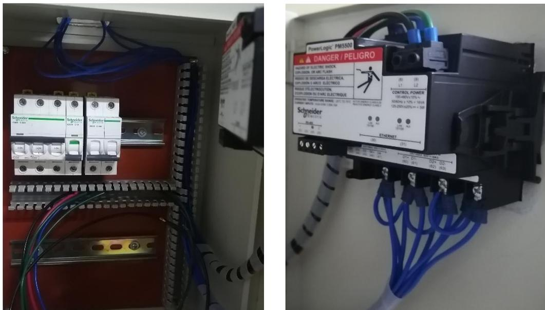
Figura 19. Cableado del analizador de redes PM5560
