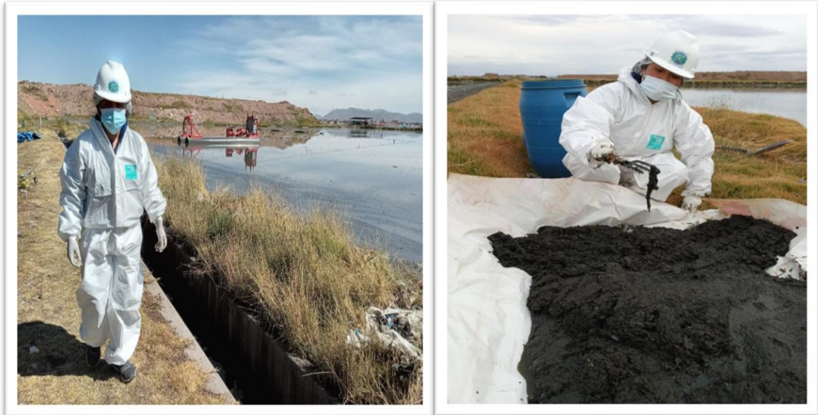
Figura 23. Extracción de lodos en las lagunas de estabilización de Juliaca.
