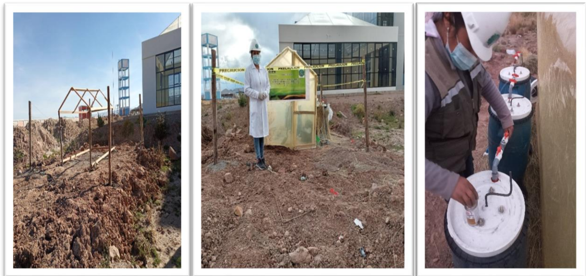
Figura 26. Construcción de la estructura para el acondicionamiento de la temperatura.
