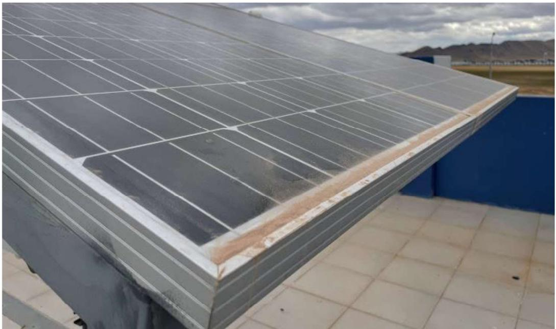
**Figura 22.** Sistemas fotovoltaicos de ambas tecnologías expuestos al polvo – estación seca, 5 de agosto del 2022.
