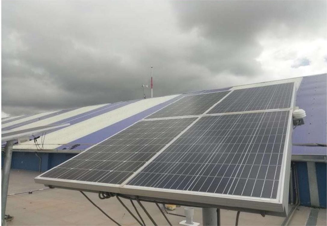
**Figura 19.** Sistemas fotovoltaicos de ambas tecnologías en la parte superior con limpieza y en la inferior expuestos al polvo – estación lluviosa, 18 de diciembre del 2021.
