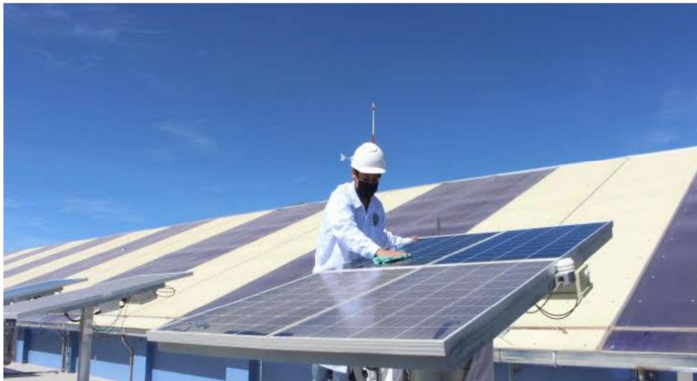
**Figura 17.** Limpieza de los módulos fotovoltaicos de ambas tecnologías en la parte superior con limpieza y en la inferior expuestos al polvo – estación seca, 18 de mayo 2022.
