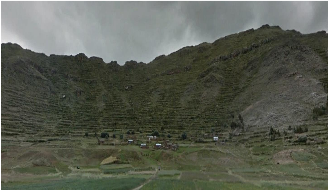
Figura 38. Vista de frente de la zona 4
