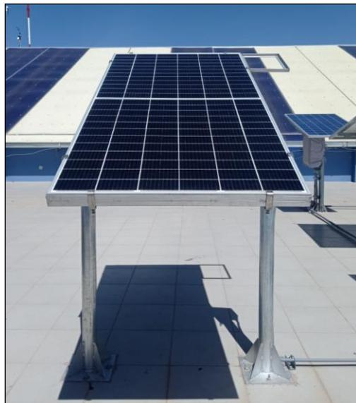
**Figura 13.** Módulo fotovoltaico bifacial monocristalino de 405 W.
