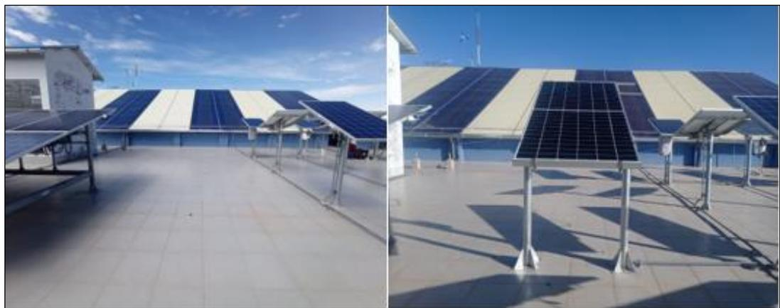
**Figura 22.** Instalación del módulo fotovoltaico bifacial.
