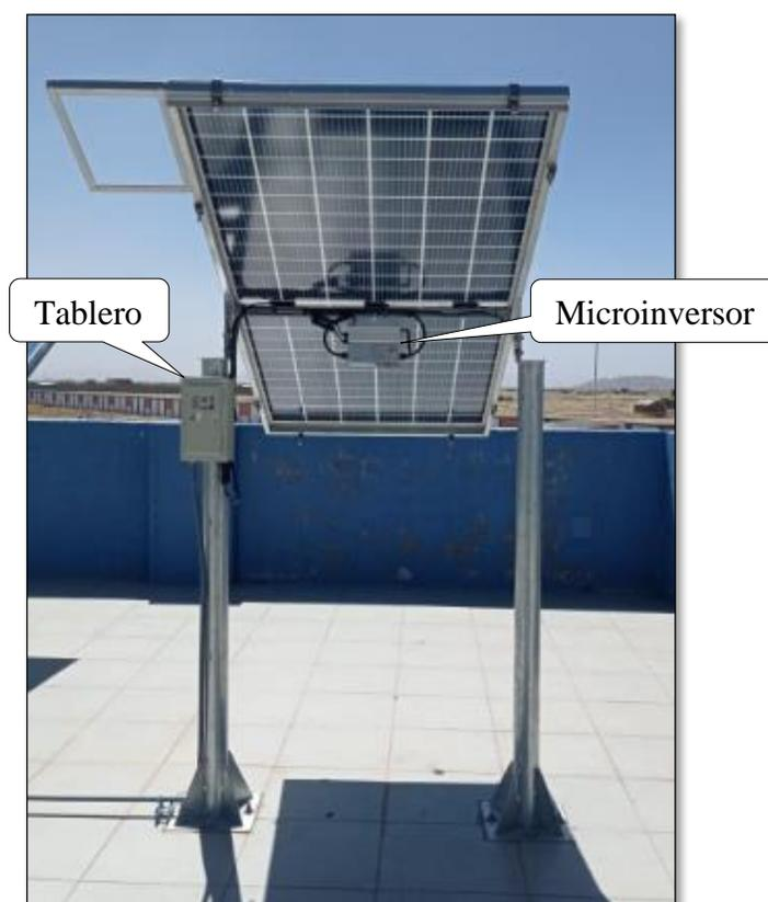
**Figura 25.** Instalación de microinversor y tablero de medición de energía en CC.
