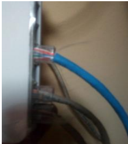
Figura 16. Comunicación por cable ethernet
