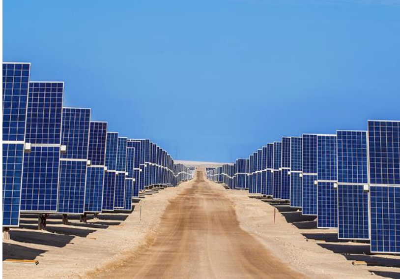
Figura 7. Central solar Rubí conectado a la red – Perú (ENEL , 2018) Fuente: ENEL , 2018)
