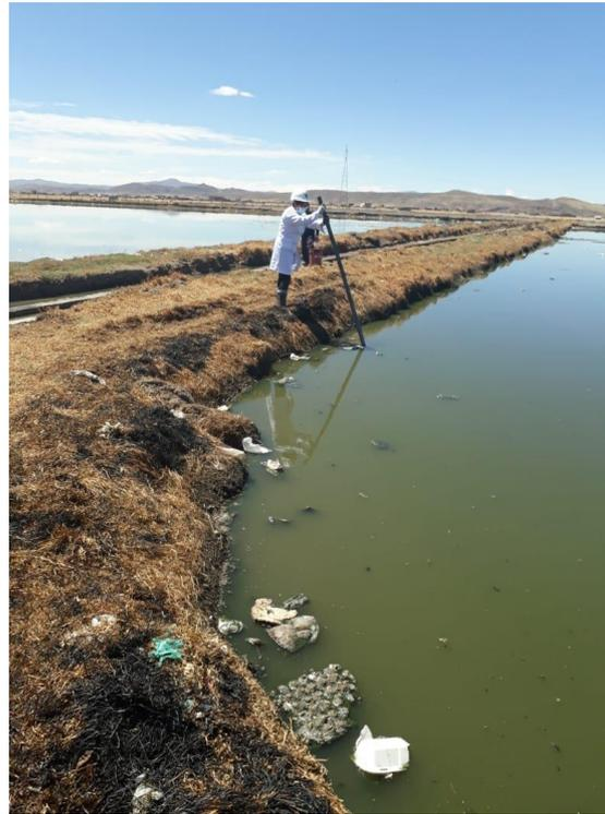
Figura 12. Extracción de lodos en las lagunas de estabilización de Juliaca.
