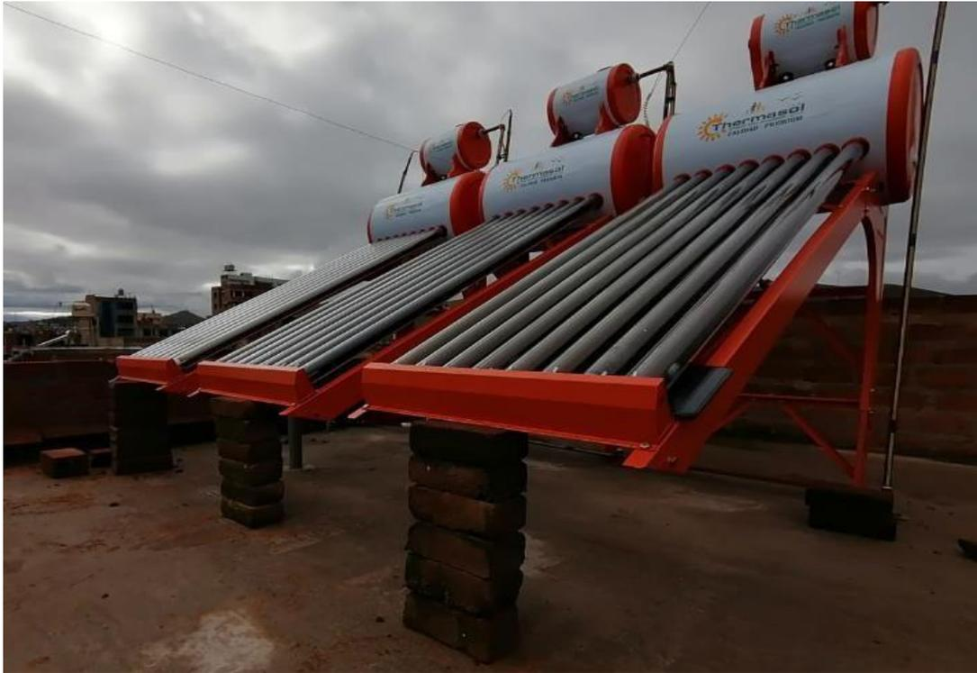
**Figura 3.6:** Termas solares instaladas a un ángulo de 25° de inclinación
