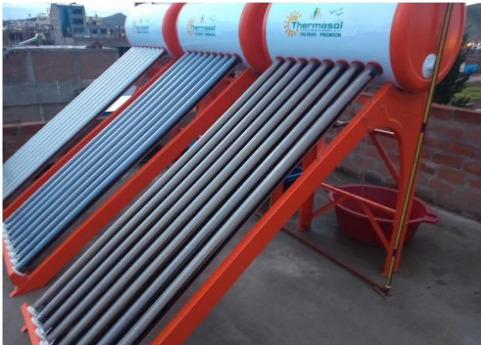
**Figura 3.5:** Termas solares instaladas a un ángulo de 35° de inclinación
