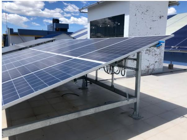
**Figura 3.42. SFCR con inductor String de 3kW (Elaboración propia).**
