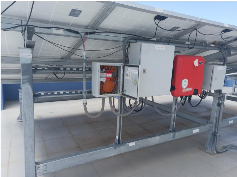
**Anexo 421: Sistema de monitoreo y adquisición inalámbrico instalado en la parte posterior de los tableros de protección del SFCR de 3kW (Elaboración propia).**
