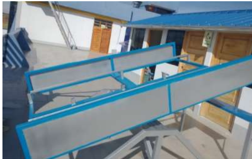
Figura 42. Instalación de la primera estructura de banco de ensayos.
