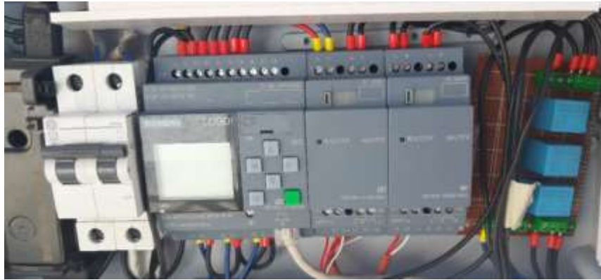
Figura 45. Disposición de dispositivos en el tablero de control.
