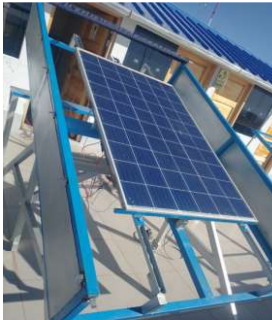
Figura 52. Módulo Fotovoltaico colocado en la estructura de Post-acondicionamiento para poder realizar el trazado de curva correspondiente.
