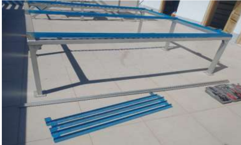
Figura 43. Instalación de la estructura de pre acondicionamiento.
