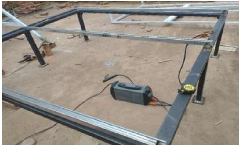
Figura 41. Estructura en construcción para el banco de pruebas de pre acondicionamiento y post acondicionamiento.
