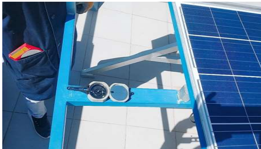
Figura 65. Colocación al ángulo azimutal según a la hora y el día correspondiente.
