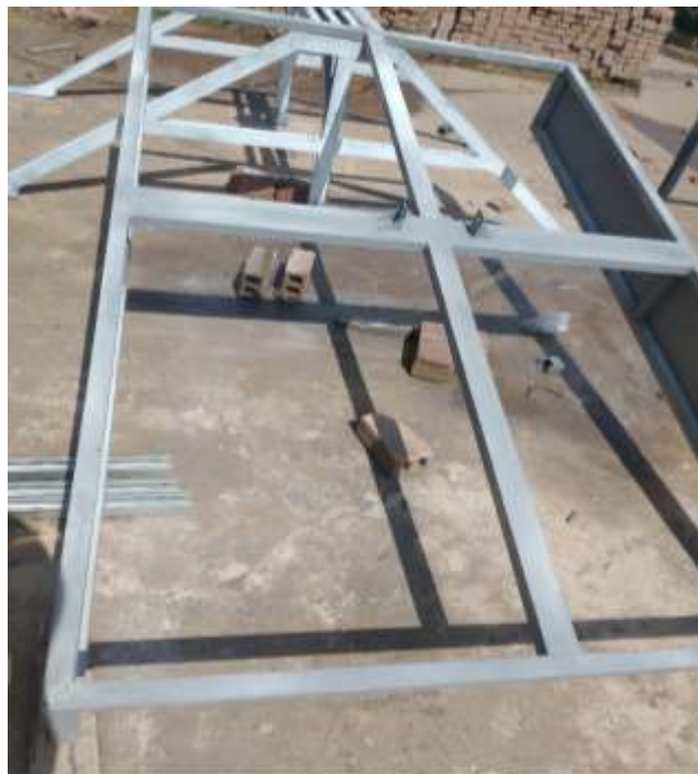
Figura A.4. Pintado de la estructura
