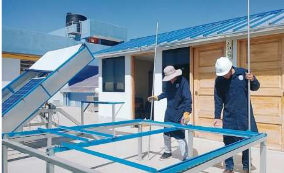
Figura A.5. Armado de las dos estructuras
