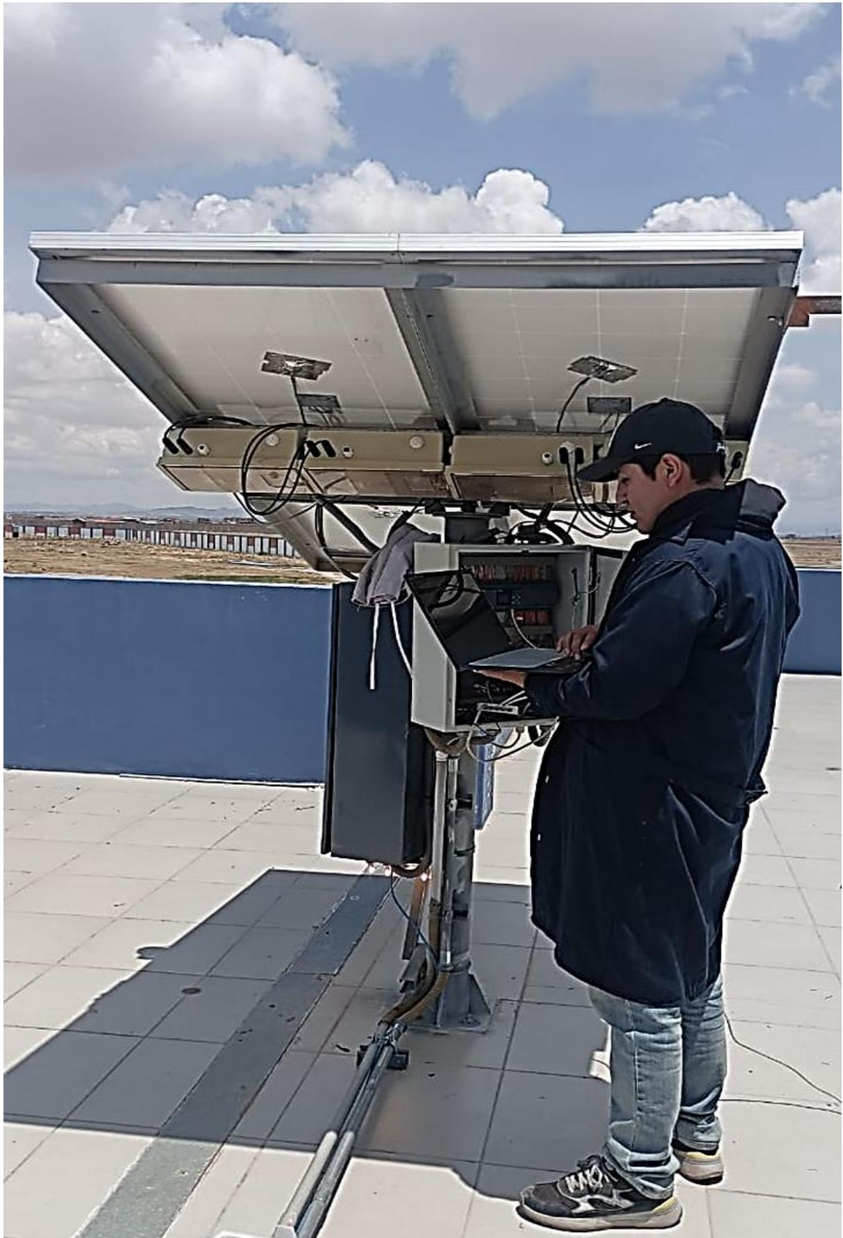
*Figura 55.* Instalación de los equipos de línea Victron 4
