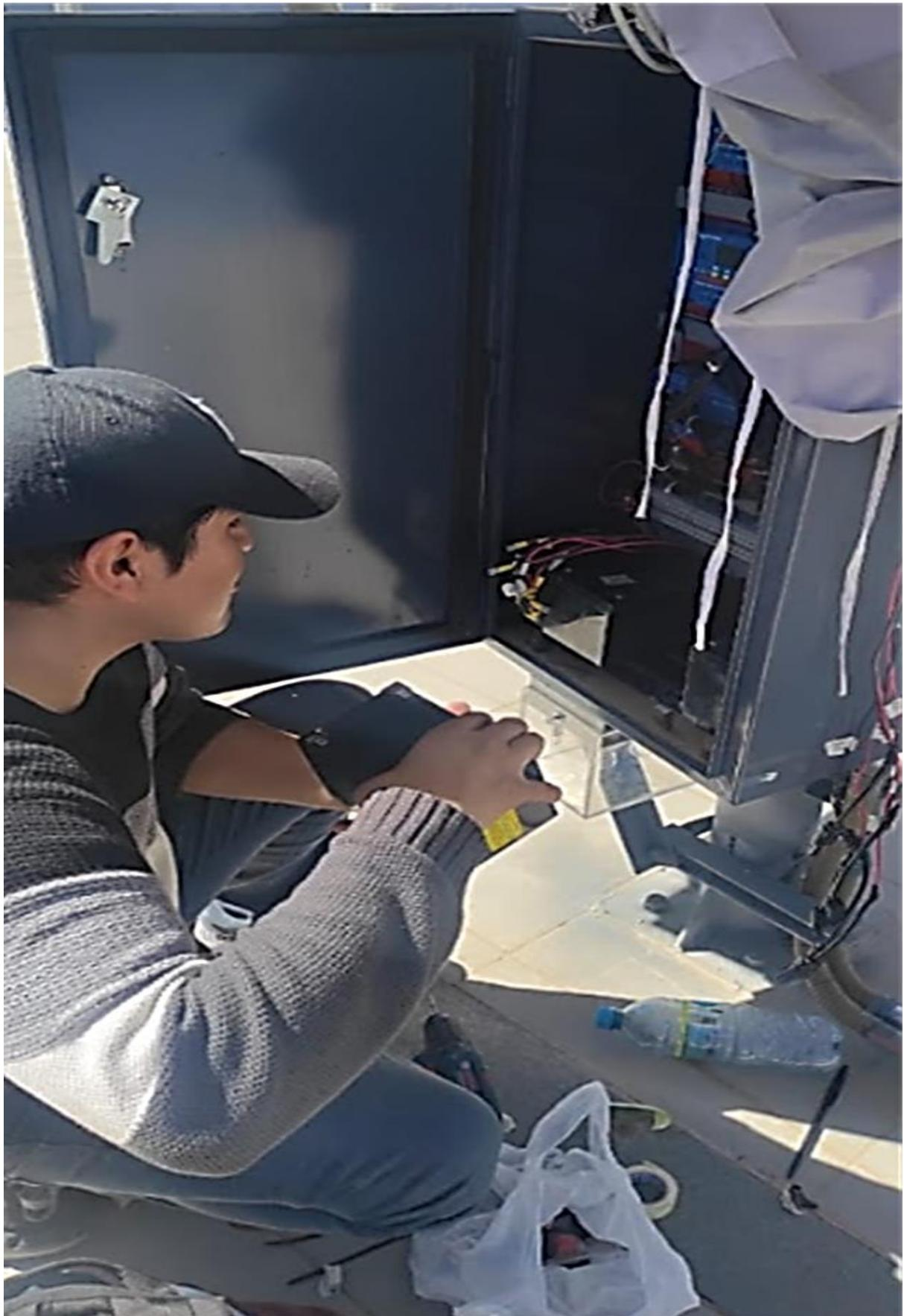
*Figura 52.* Instalación de los equipos de línea Victron 1
