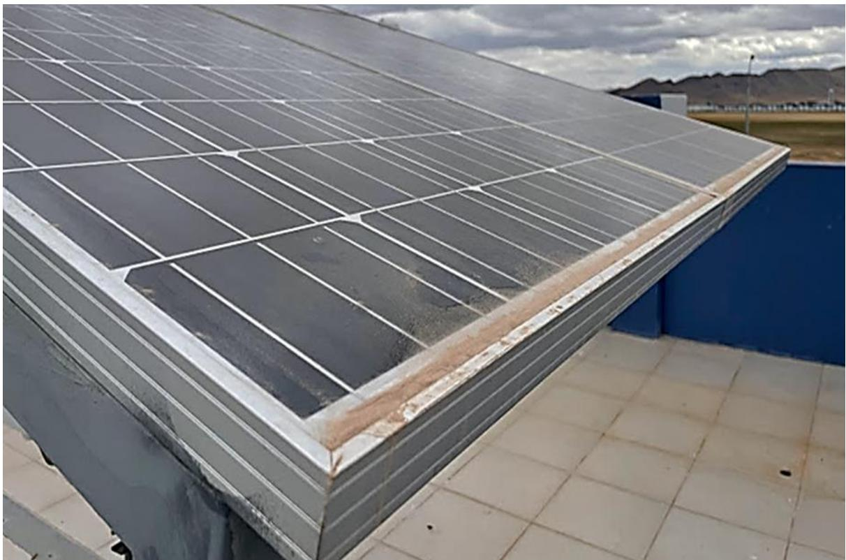
*Figura 49.* Sistemas fotovoltaicos de ambas tecnologías expuestos al polvo – estación seca, 5 de agosto del 2023
