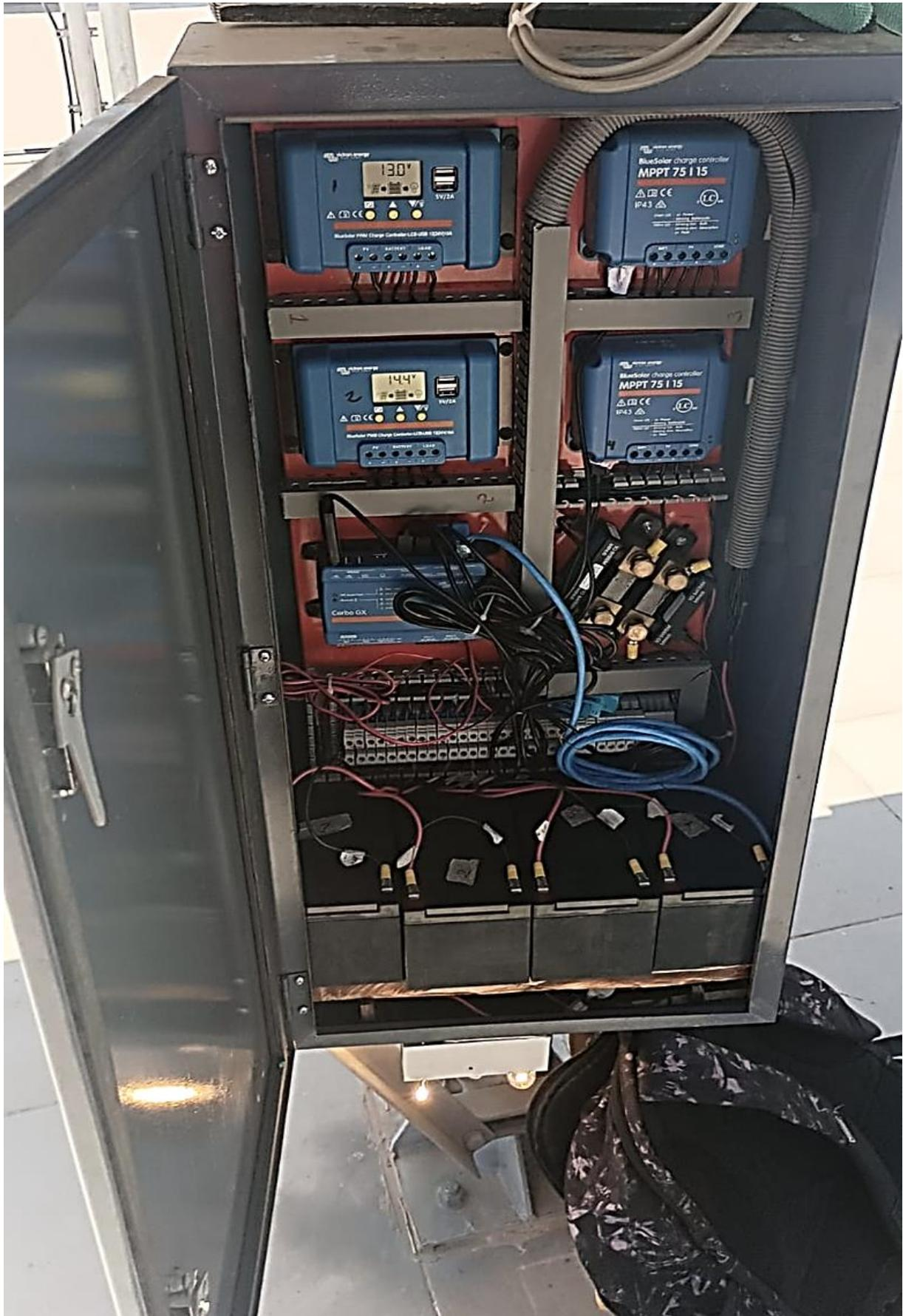
Figura 54. Instalación de los equipos de línea Victron 3
