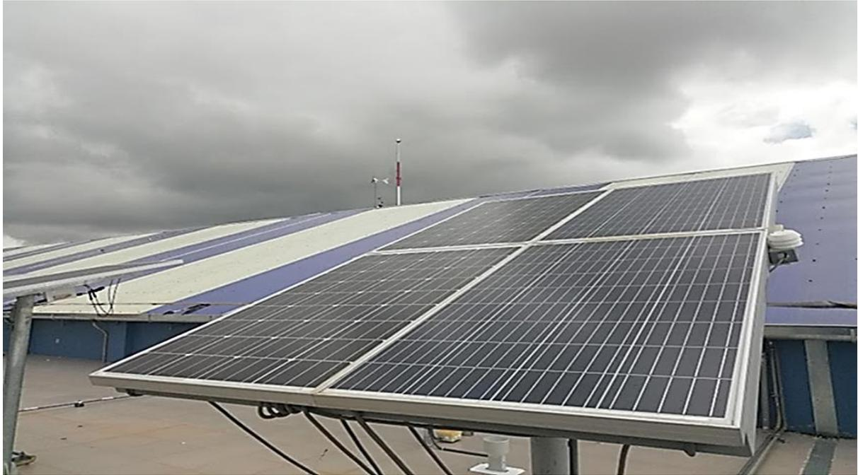
*Figura 46.* Sistemas fotovoltaicos de ambas tecnologías en la parte superior con limpieza y en la inferior expuestos al polvo - estación lluviosa, 18 de diciembre del 2022
