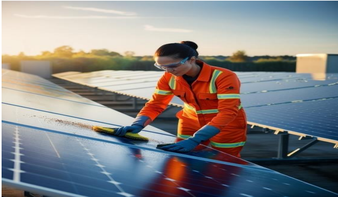
Figura 73. Limpieza de una celda fotovoltaica (Tiwari & Kalamkar, 2018)
