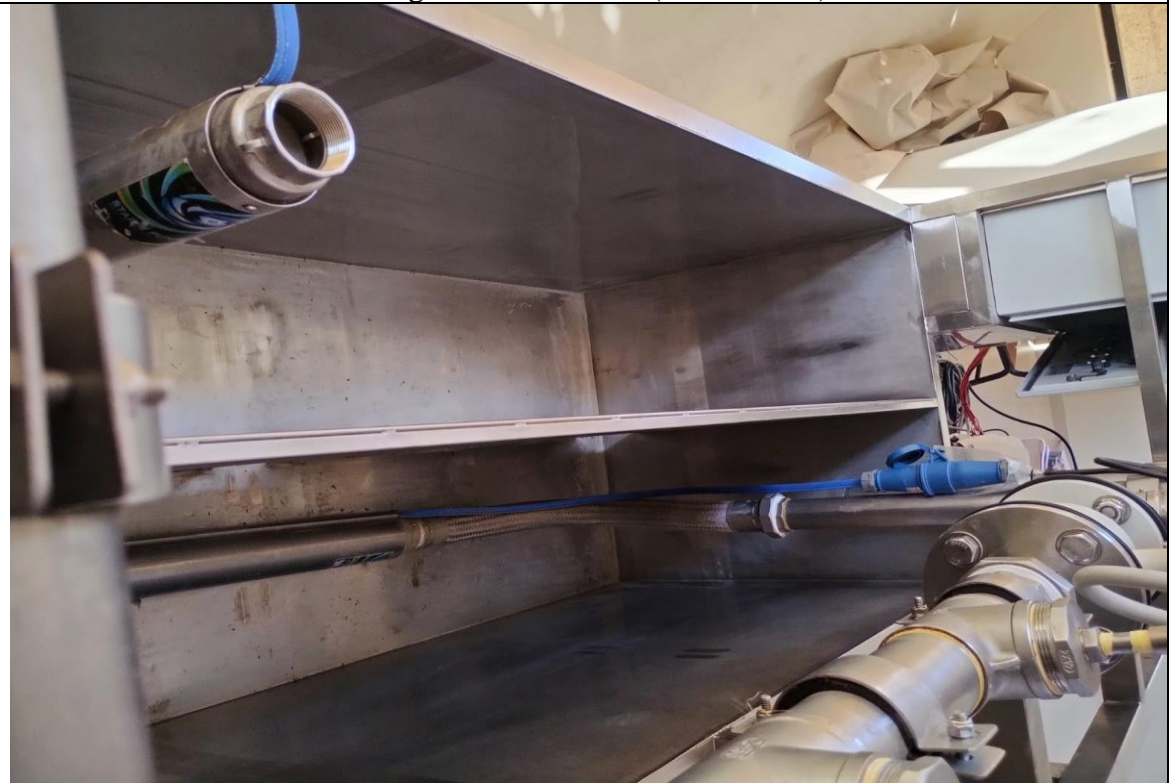
Colocación de la bomba stairs
