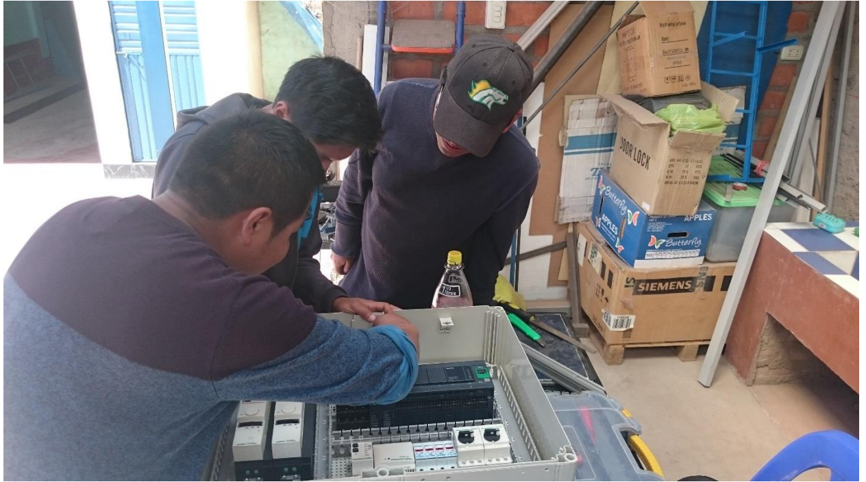
Instalación del tablero de Control del sistema Hidráulico, Cableado, junio del 2016
