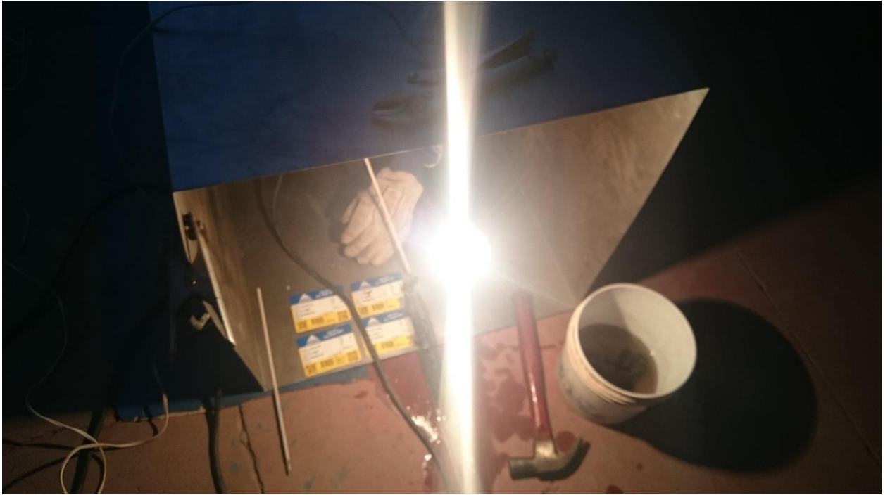
Construcción del Acumulador, Soldadura, junio del 2016
