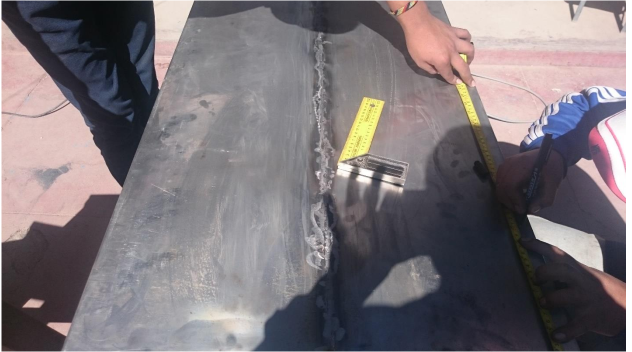
Dimensionamiento de la estructura metálica, acumulador, junio del 2016
