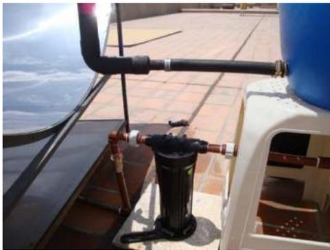
Figura 3. Filtro previo al ingreso de agua al tanque alimentador
