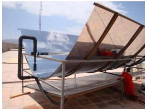
Figura 4. Vista del colector parabólico y de la placa condensadora a la sombra del colector
