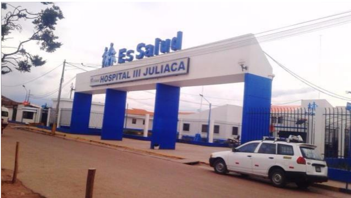
Fotografía 4. Hospital III Juliaca
