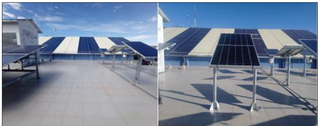
Figura 22. Instalación del módulo fotovoltaico bifacial.
