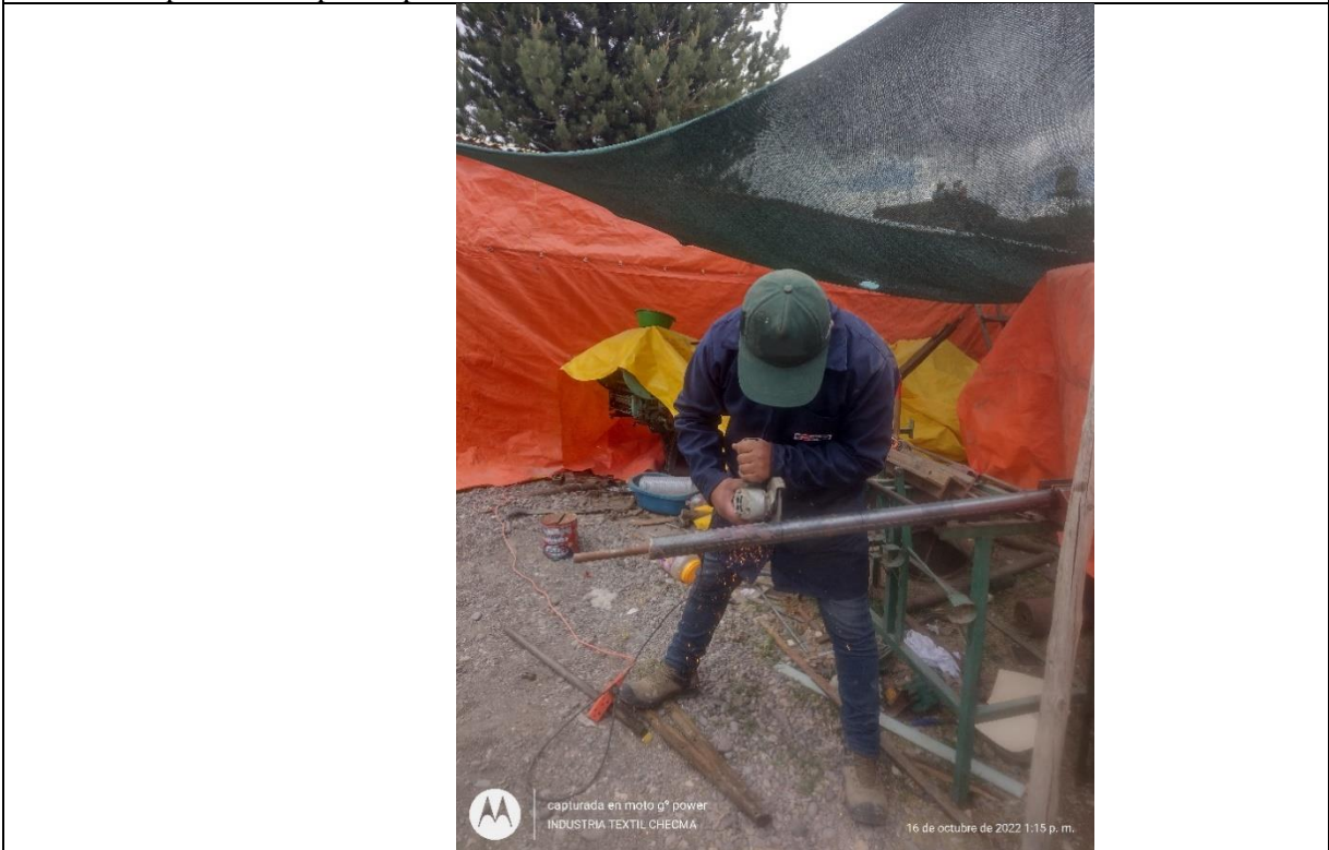
Preparación de los materiales metálicos según las medidas adecuadas.
