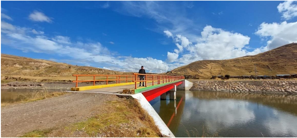
Fotografía en el puente Sundaya obra ejecutada por la MDA, y visita a domicilios aledaños.
