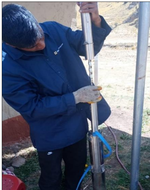
Figura 36. Armado de la bomba sumergible de rotor helicoidal.
