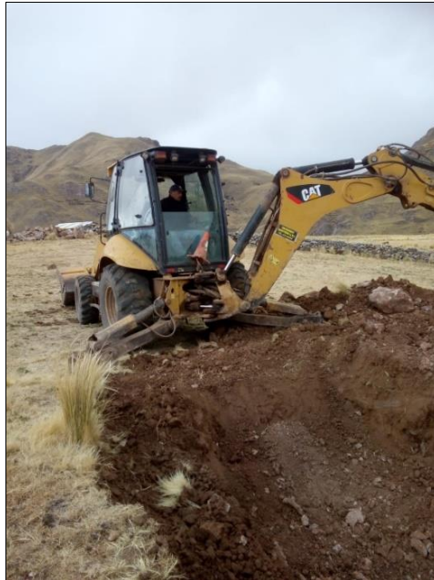
Figura 42. Construcción del sistema de almacenamiento de agua.
