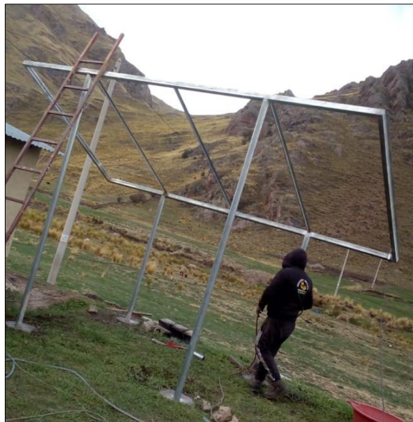
Figura 34. Montaje y armado de la estructura de los paneles.
