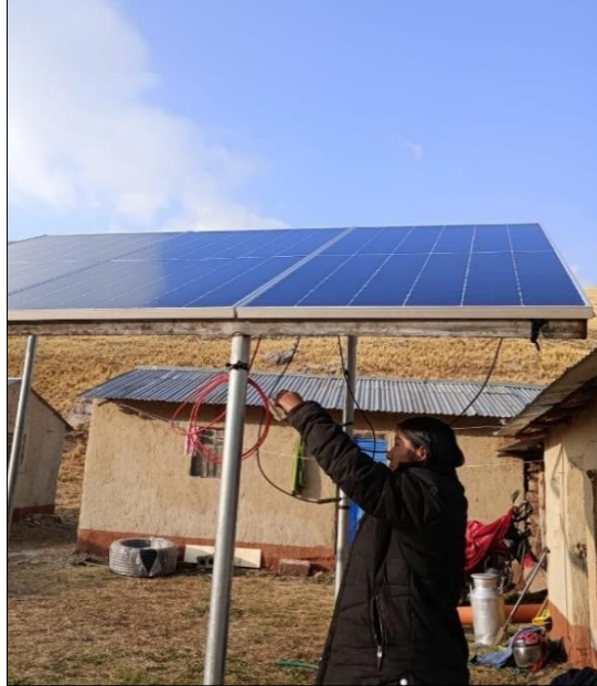
Figura 35. Montaje de los módulos fotovoltaicos.
