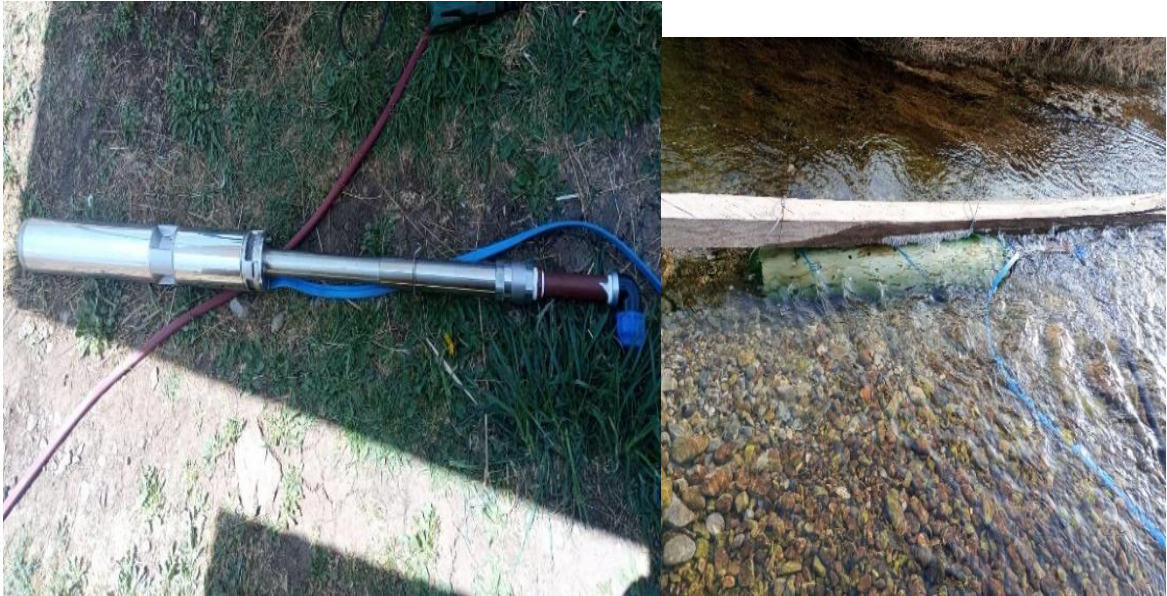
Figura 38. Instalación de la bomba sumergible NASTEC 4HS 01/03H MP.
