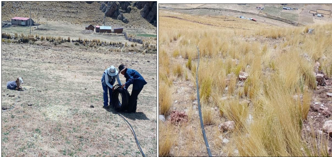
Figura 39. Tendido de la manguera polietileno HDPE 1" PN 16.
