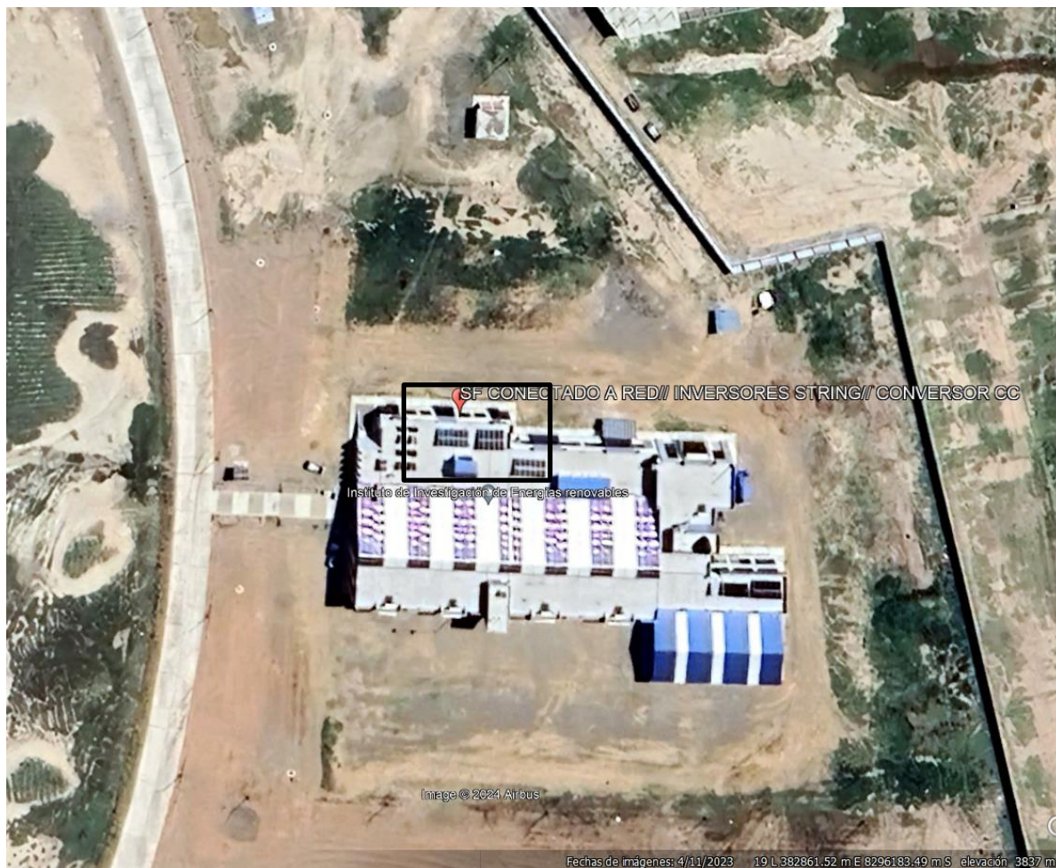
Figura 11. Ubicación del lugar de estudio de los sistemas fotovoltaicos conectados a la red con tecnología de inversor string y convertidores cc-cc (Google Earth, 2023).
