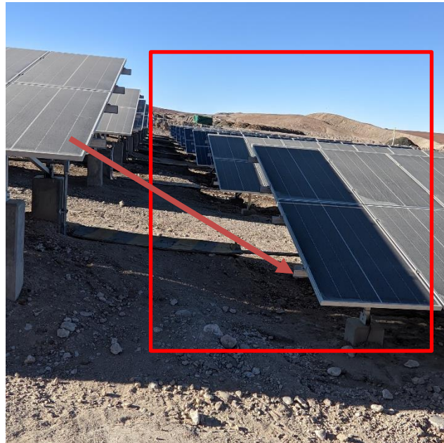
Figura 43: Ubicación de sombras de forma horizontal en la planta solar la bonita. (Elaboración propia)
