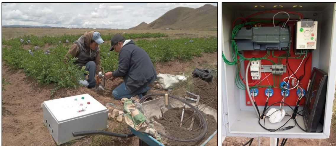
Instalación de sensores de temperatura
