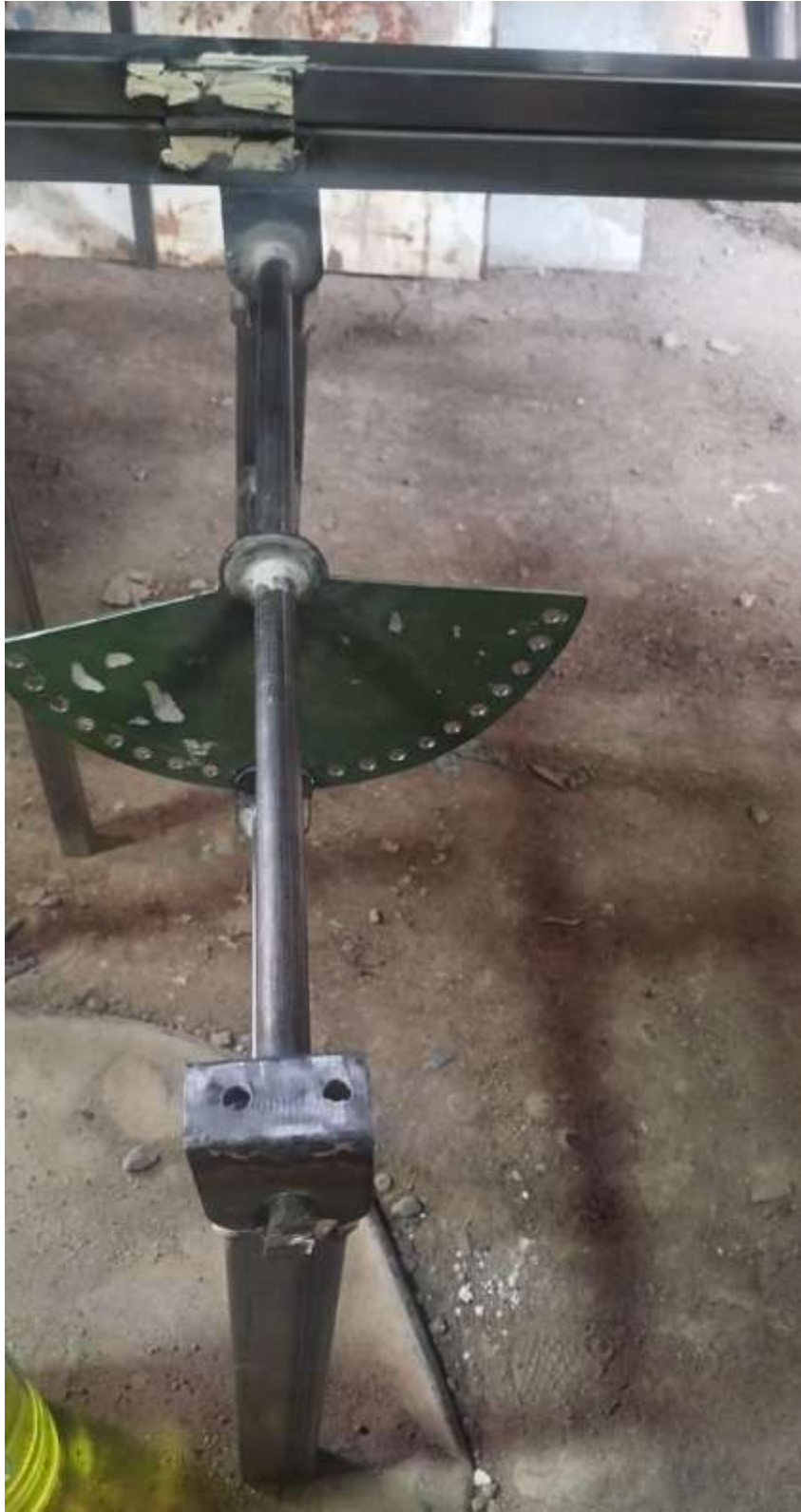
Estructura del panel solar en construcción
