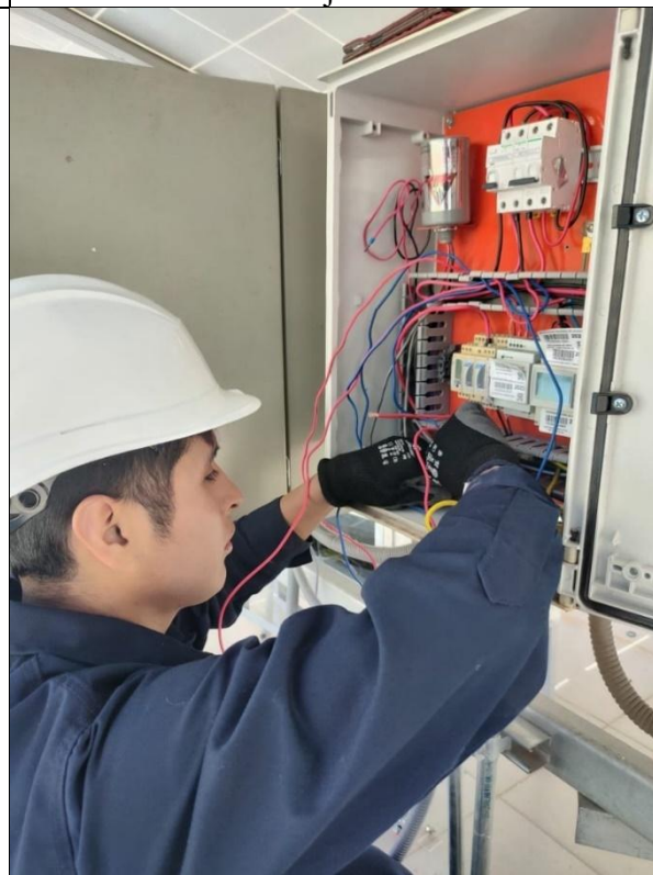
Conexión de equipos en el tablero AC.
