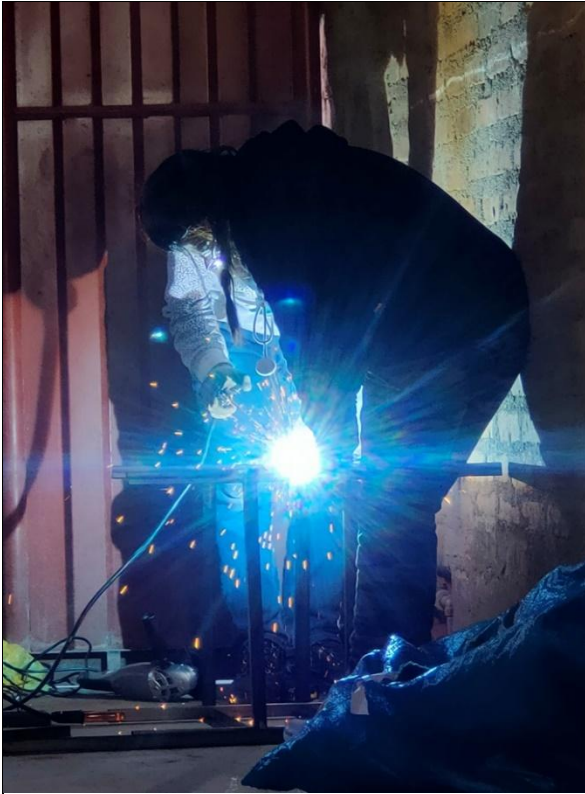
Armado de la estructura metálica (batería).
