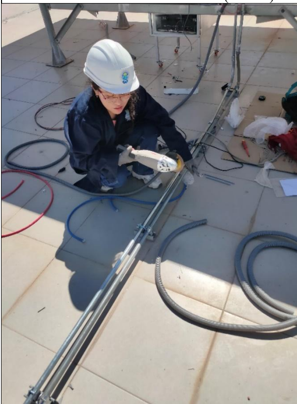
Armado del Conduit eléctrico.
