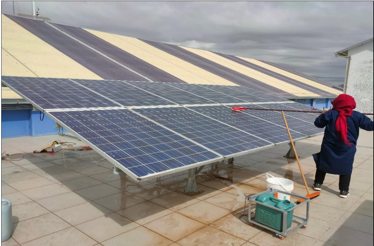
Mantenimiento de módulos fotovoltaicos.
