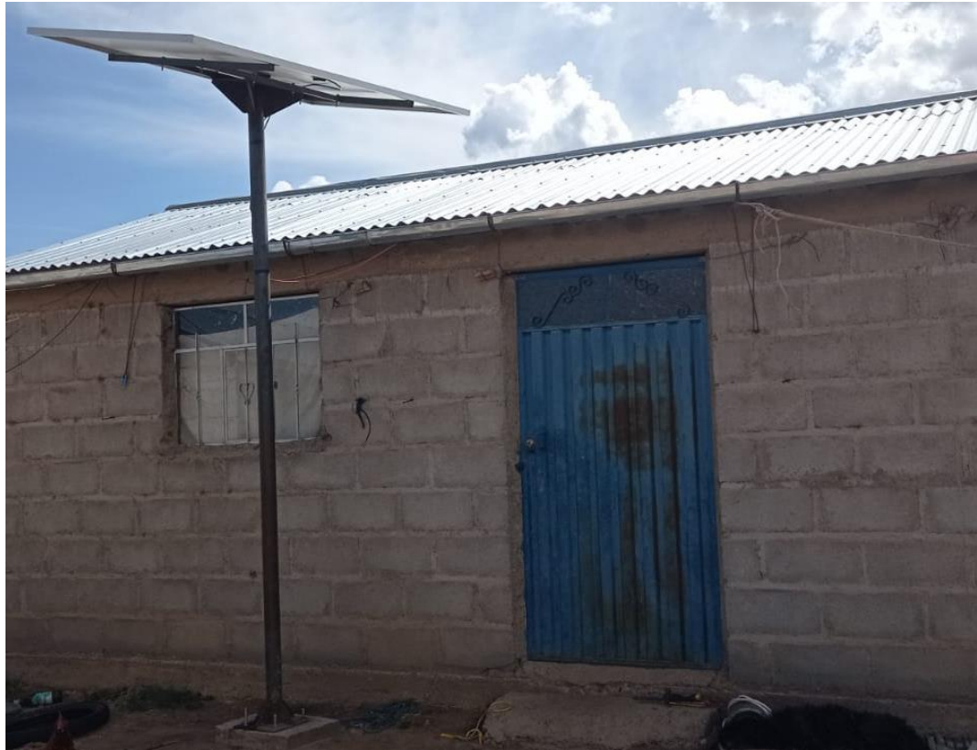
Figura 27. Instalación de monoposte con panel solar
