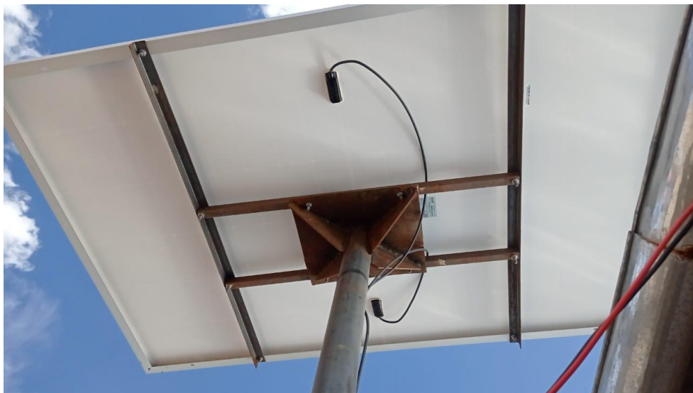
Figura 29. Instalacion de modulo fotovoltaico
