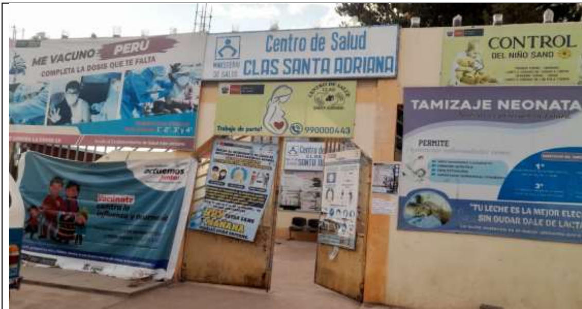
Proyecto Salud Código de proyecto: 2455444 Nombre: Mejoramiento de los servicios de salud del centro de salud Clas Santa Adriana (nivel I-4) distrito de Juliaca - provincia de San Román - departamento de Puno En esta fotografía se muestra el estado en que se encuentra actuar el proyecto de centro de salud.
