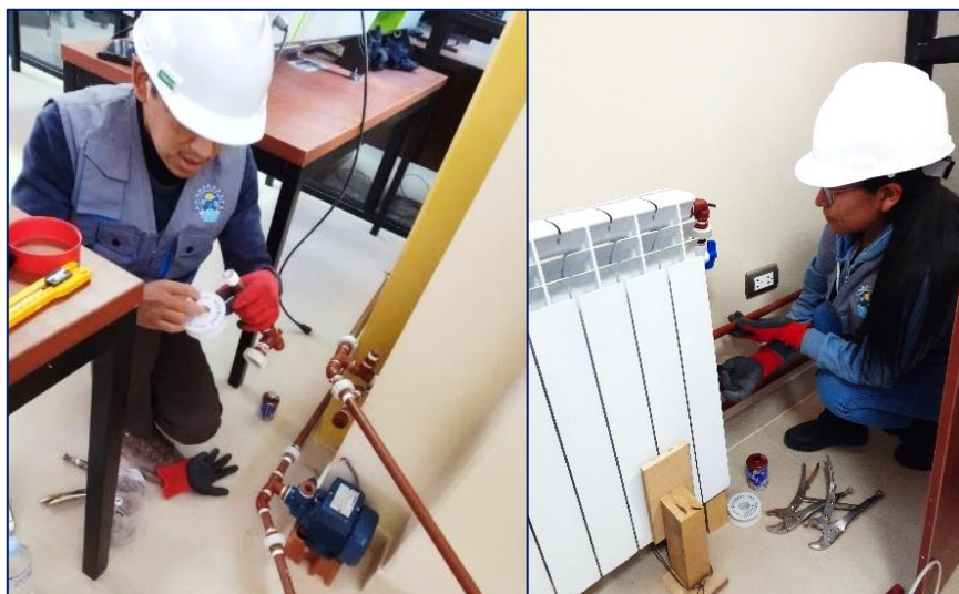
Figura 71. Instalación de la bomba hidráulica y radiadores.
