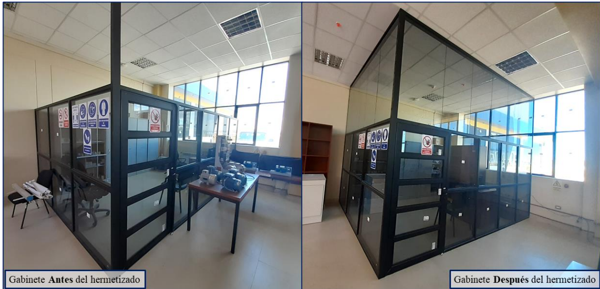
Figura 70. Hermetizado del gabinete del Laboratorio de Control y Automatización.
