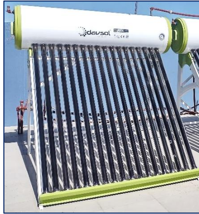
Figura 62. Calentador solar de 18 tubos de vacío termosifónicos seleccionado.
