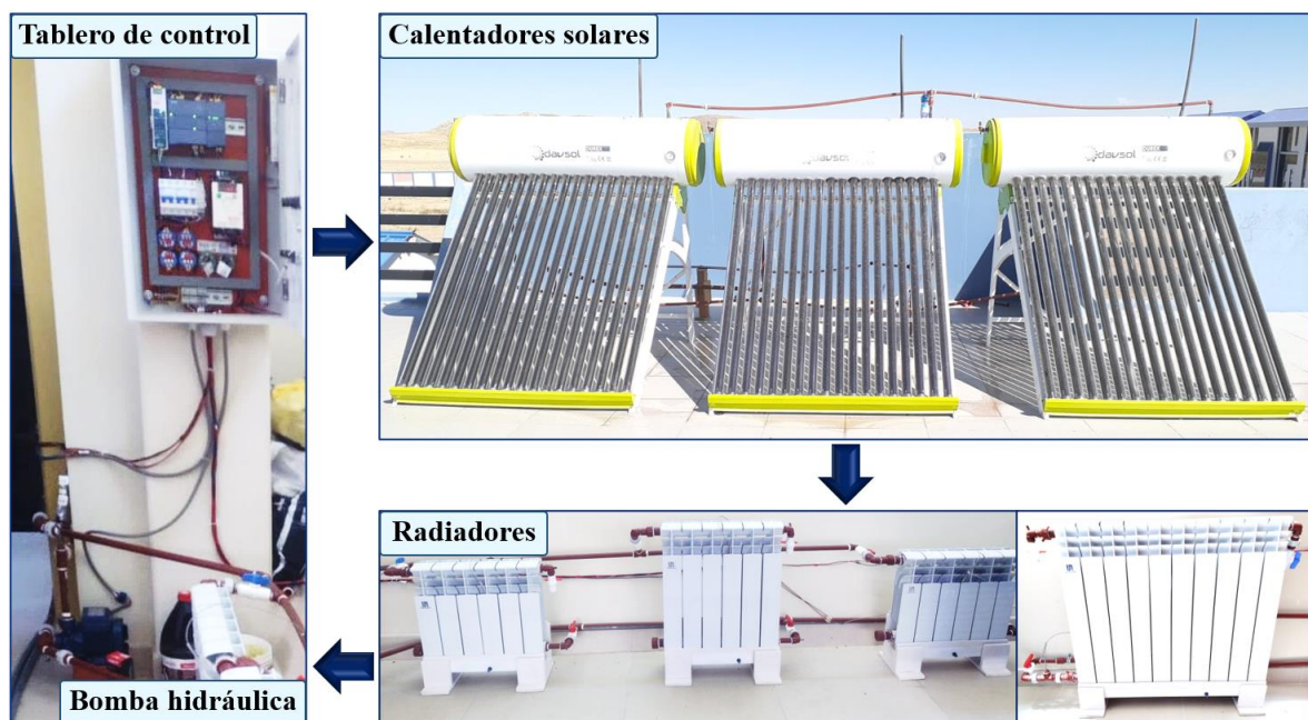
Figura 40. Sistema de calefacción solar térmica en el Laboratorio de Control y Automatización.
