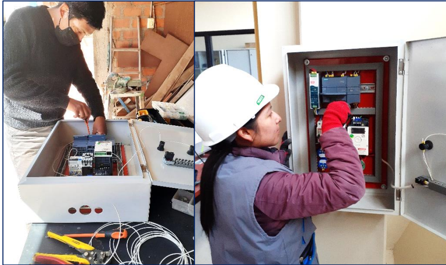
Figura 74. Instalación del gabinete y tablero de control.
