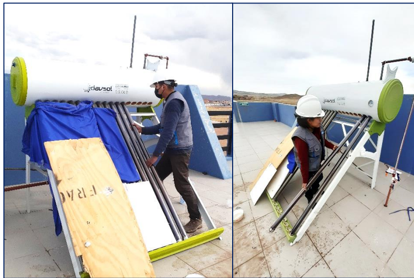
Figura 72. Instalación de los calentadores solares.
