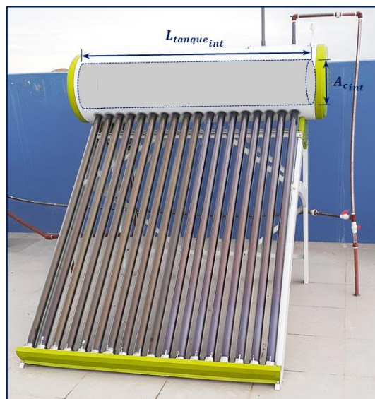
Figura 67. Dimensiones del interior del termotanque del calentador solar.
