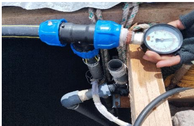
Figura 25. Montaje del 1er Manómetro.
