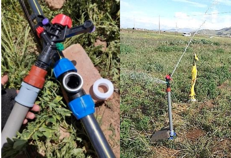
Figura 24. Montaje de los aspersores.
