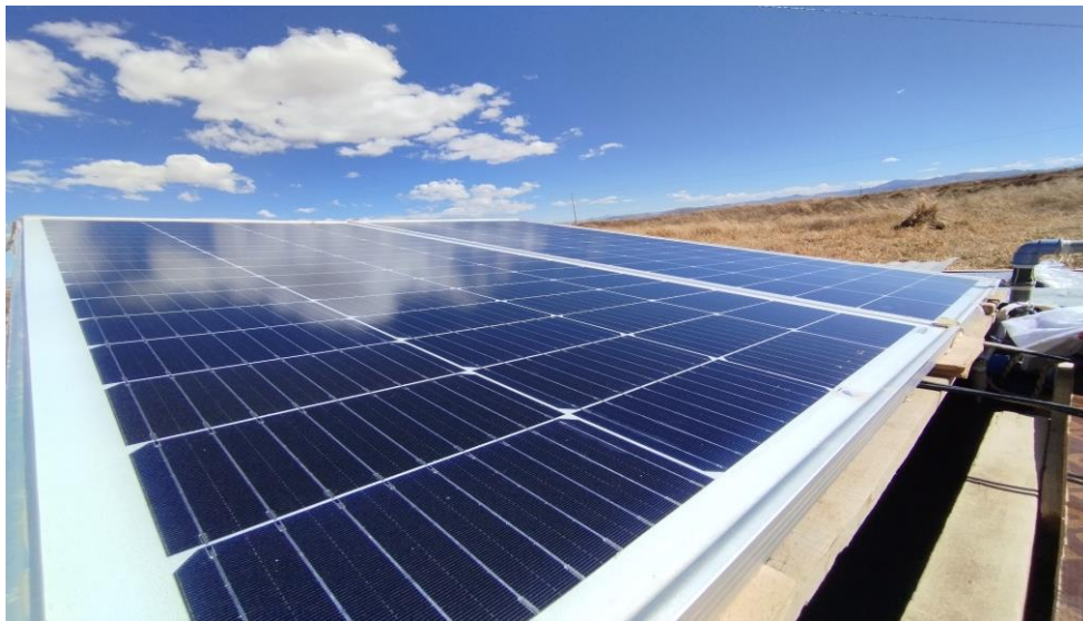
Figura 21. Montaje del sistema fotovoltaico.
