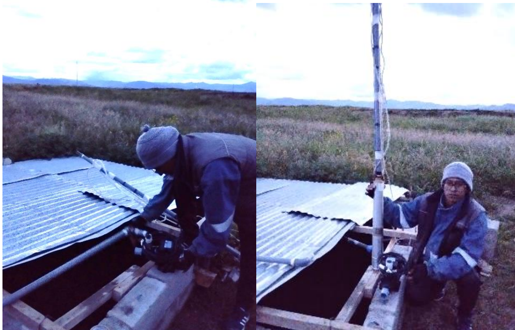
Figura 22. Instalación de las bombas solares.
