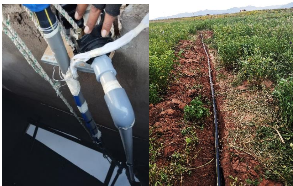
Figura 23. Instalación de la conducción hídrica.
