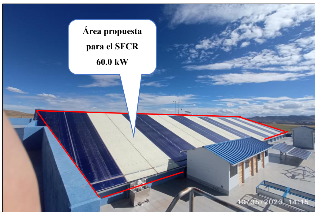
Figura 33. Cobertura de la planta superior del IEREE.
