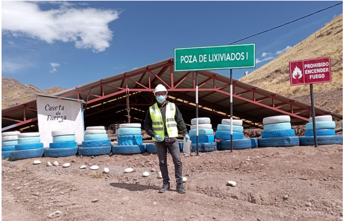
Figura 4. Poza de lixiviados operativa de la celda transitoria de Huanuyo.
