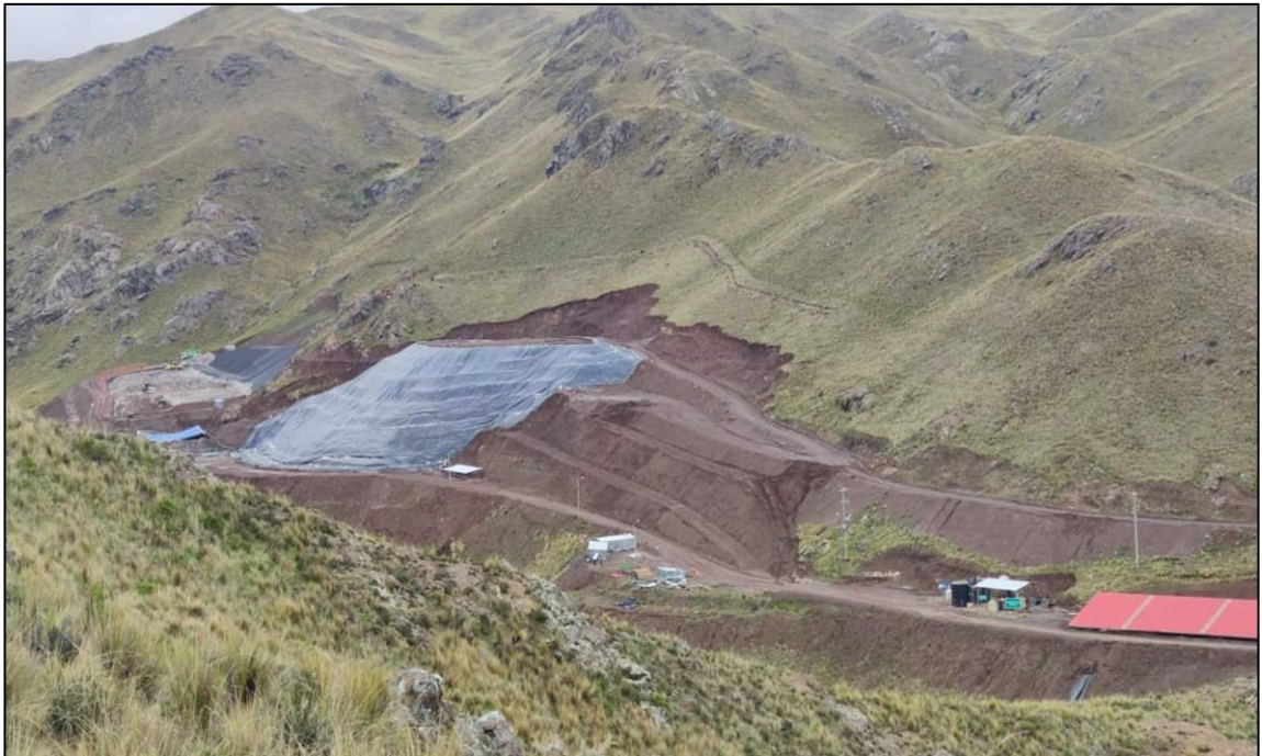
Figura 3. Ubicación y estado de las celdas transitorias y poza de lixiviados de Huanuyo.
