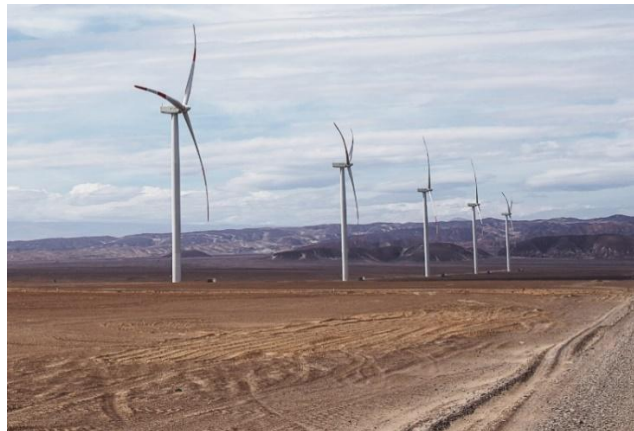
Figura 29. Sistema de energía eólica terrestre u onshore (ENEL, 2020).
