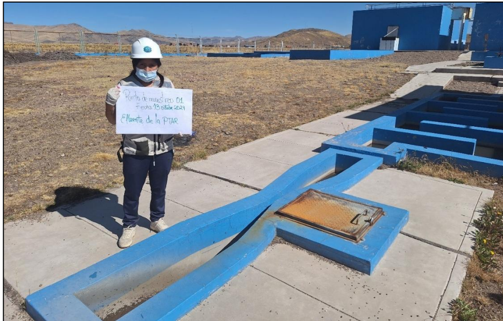
Foto 1 Punto de muestreo 1, efluente de la PTAR Lampa
