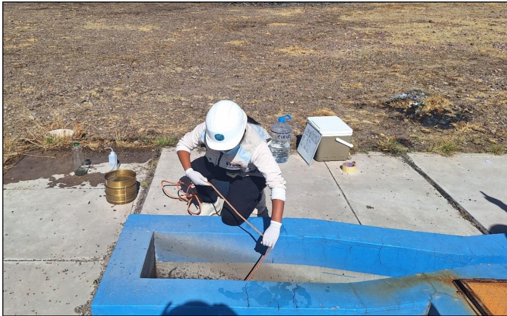
Foto 5 Toma de muestra en el efluente de la PTAR Lampa
