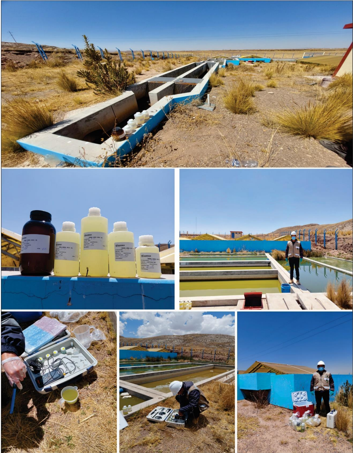
Figura 15. Planta de tratamiento de aguas residuales del distrito de Caminaca.
