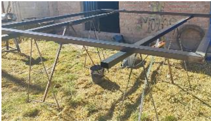
Figura 12. Construcción de la estructura para los módulos fotovoltaicos.
