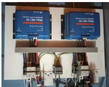
Figura 17. Instalación del tablero para los módulos fotovoltaicos.
