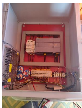
Figura 18. Instalación del tablero de monitoreo y control.
