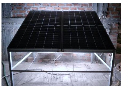
Figura 16. Instalación de los módulos fotovoltaicos.
