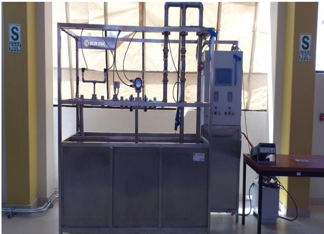
Figura 12. Módulo de pruebas de bombas con generación solar fotovoltaica (Fuente propia).
