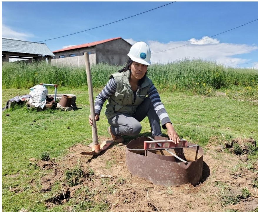
Figura 20. Nivelación para la medición de capacidad de infiltración del suelo
