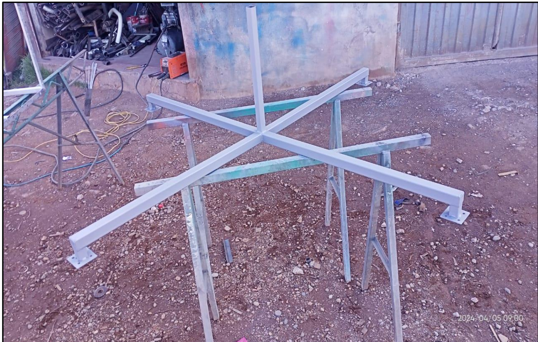
Figura 32. Base de estructura del módulo fotovoltaico con aplicación de pintura base zincromato.
