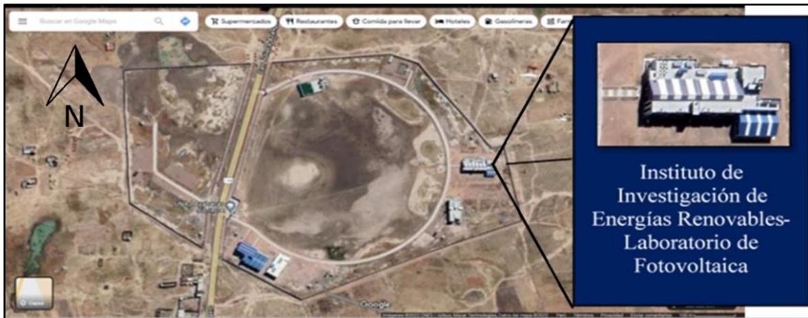
Figura 1. Vista satelital de la Sede Ayabacas – UNAJ (Google maps, 2022).
