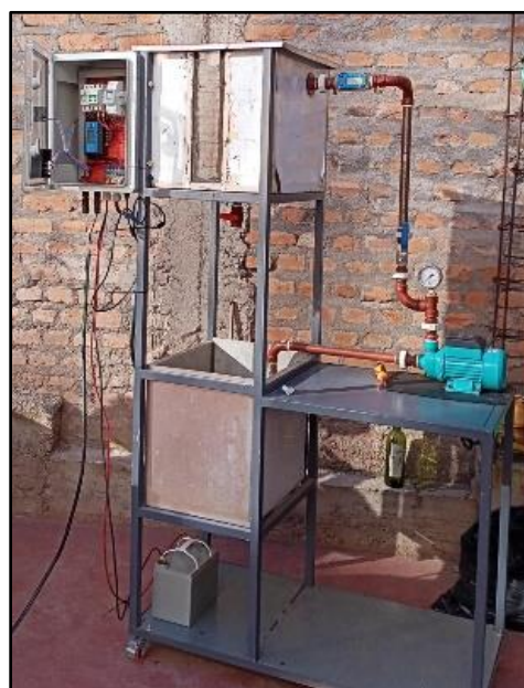
Figura 69. Sistema de bombeo en simulación de alturas.
