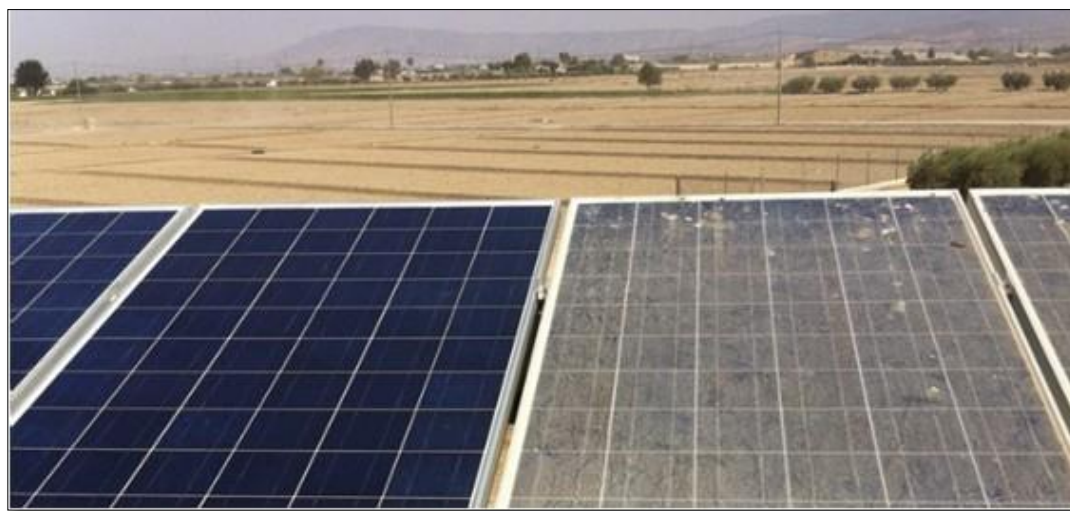
Figura 8. Acumulación de suciedad en un módulo fotovoltaico (CambioEnergetico, 2021)
