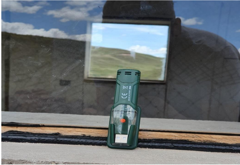
Figura 77. Medición de la temperatura y humedad relativa.
