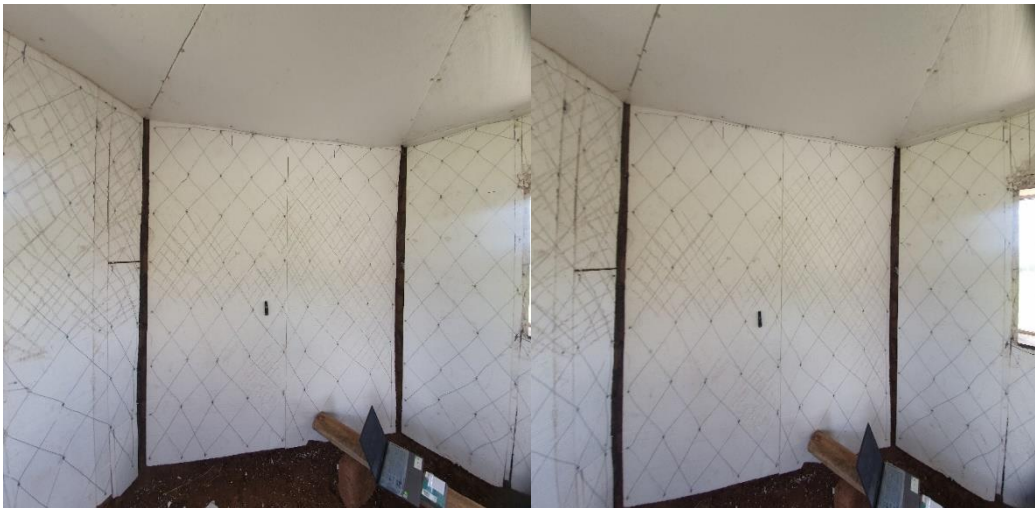
Figura 78. Vista interior de la vivienda.
