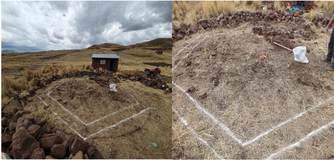
Figura 73. Delimitación del terreno para la construcción de la vivienda bioclimática hexagonal.
