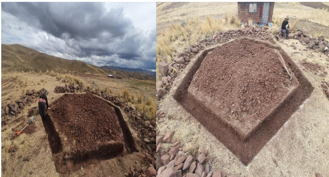
Figura 74. Excavación del terreno para la construcción.
