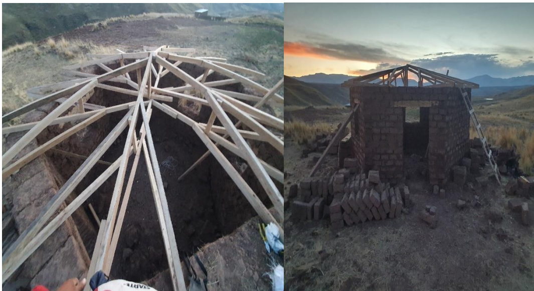
Figura 76. Armado del techo de la vivienda.
