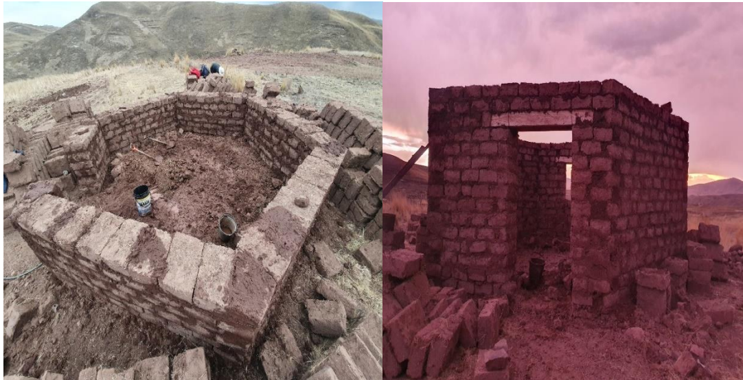
Figura 75. Colocación del muro con adobe.
