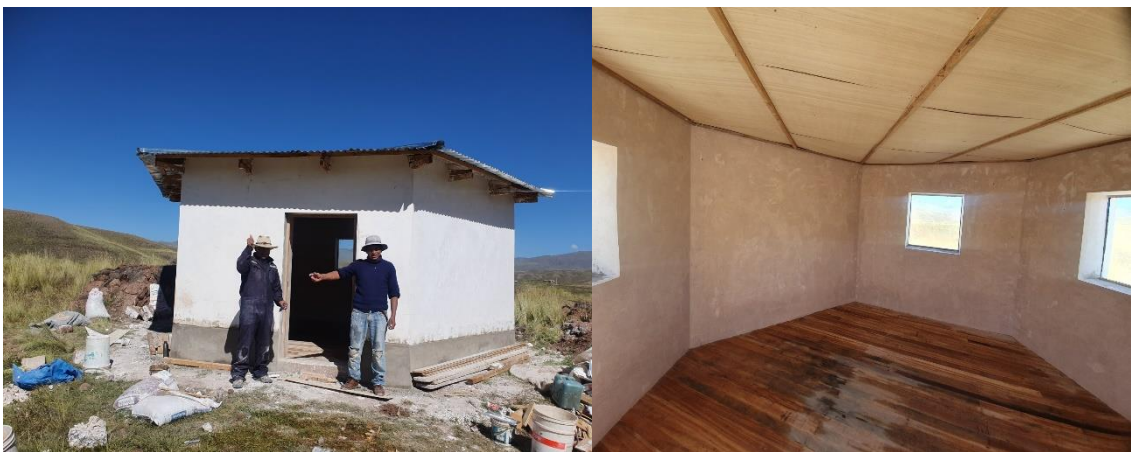
Figura 80. Vista exterior de la vivienda bioclimática con revoque de yeso en el exterior e interior.
