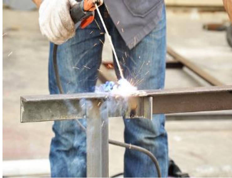
Figura 51. Armado de estructura con soldadura SMAW
