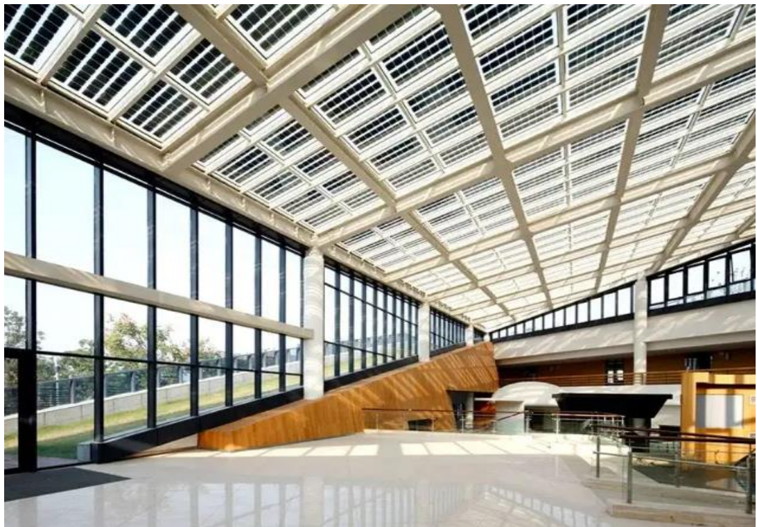
Figura 37. Visualización de MFV instalados en el techo (HIITIO, 2024).
