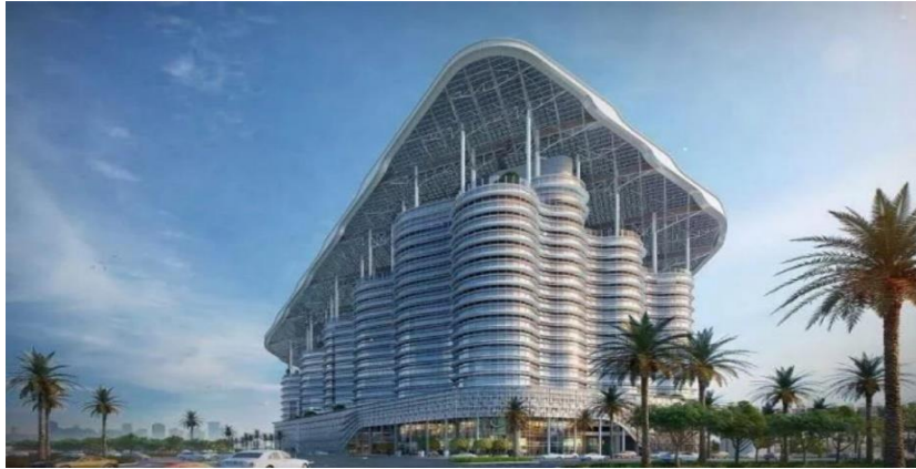
Figura 1. Mega estructura ubicada en Dubai, potencia instalada de 5MW (JinkoSolar, 2024).
