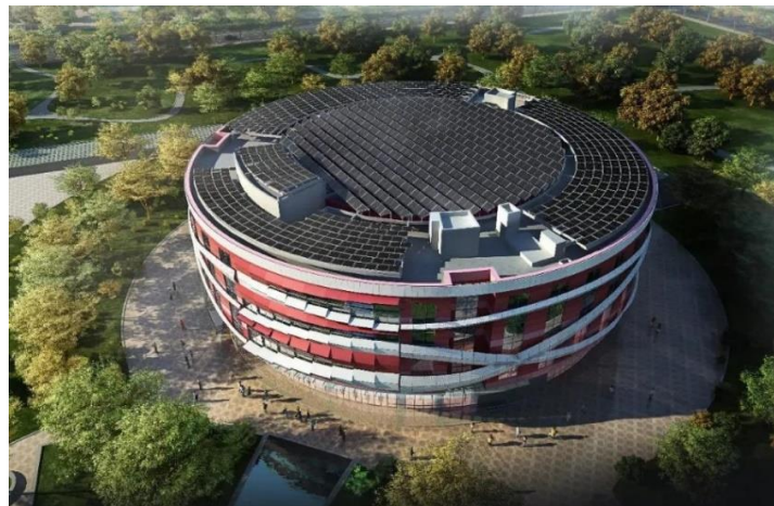
Figura 2. Edificación ubicada China, con una cantidad de MFV BIPV de 307 unidades (JinkoSolar, 2024).
