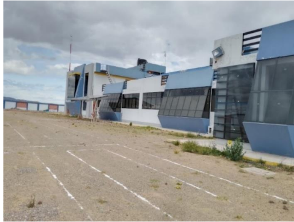
Figura 47. Ubicación de las ventanas de la fachada del instituto de energías renovables – UNAJ
