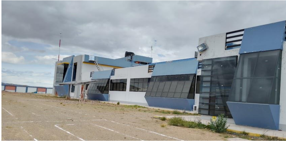
Figura 35. Fachada del instituto de la EPIER con ventanas orientadas al norte.
