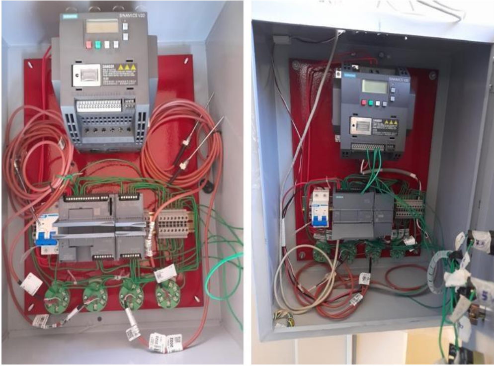
Figura 65. Armado y cableado del sistema de control.
