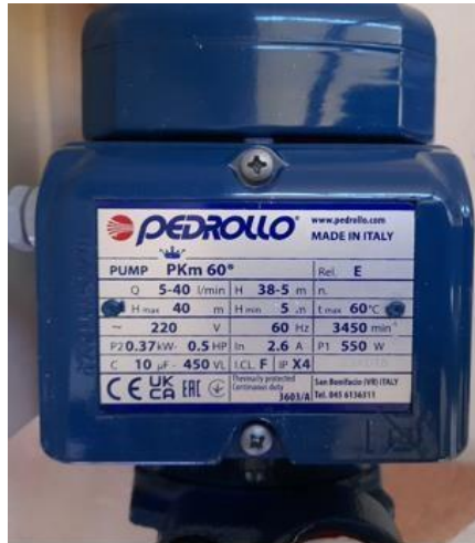
Figura 12. Bomba de agua caliente ( Pedrollo, 2020 ).
