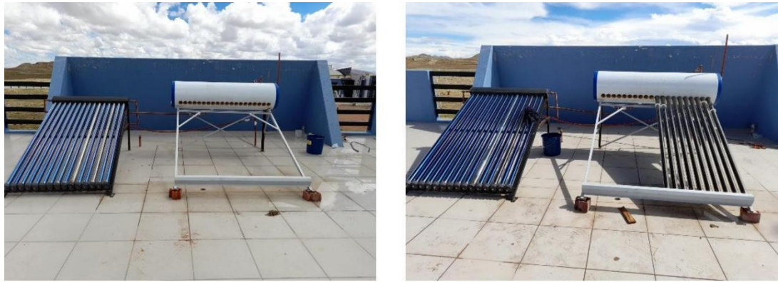
Figura 26. Instalación de colector solar de tubos de vacío y heat pipe.
