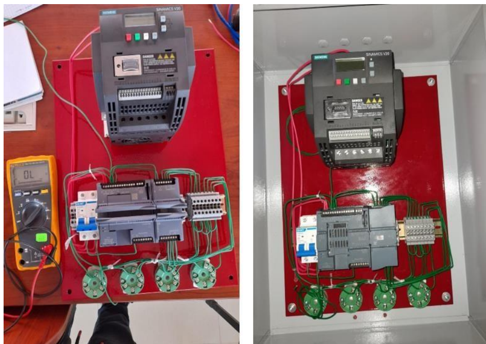
Figura 64. Prueba de continuidad, para su posterior puesto en marcha.
