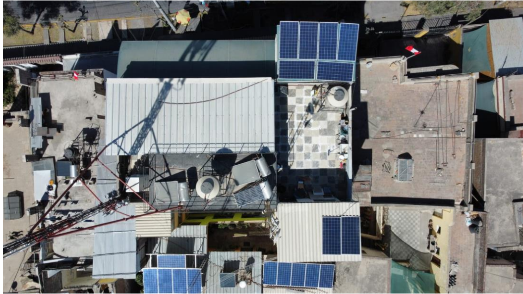
Figura 3.5.5 Verificación de sombras y espacios del área instalada.
